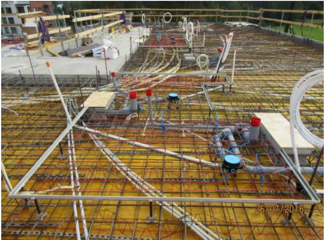
Kuva 12. Holvimuotin raudoitus, lattiakaivo, viemäriputket ja lattialämmitys [17, s. 7].
