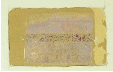
Kuva 59. Huoneen 130 viivakoriste vanhimmassa kerroksessa. Seuraava kerros on vaalean ruskea. (Myyrä 2012)
