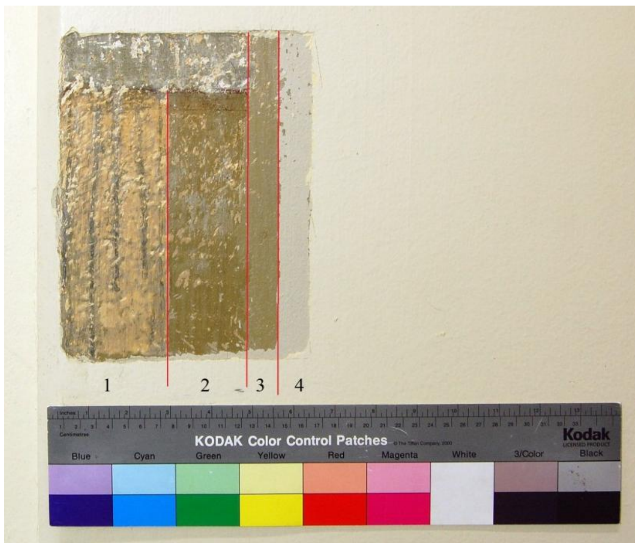
Esilleotto kerroksista 1 (1897), 2 (1908), 3 ja 4 (1939?). Kerroksen 3 vihreä voi olla peräisin 1910–20-luvuilta (ks dokumentointikortti 3 keskiaulan käsittelykerroksesta 3) tai se voi vaihtoehtoisesti olla kerroksen 4 pohjamaali.
