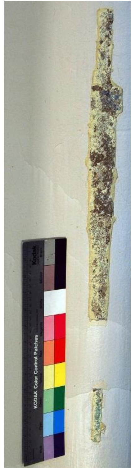
Esiinotto 2 sijaitsee pohjois- ja länsiseinän välisessä nurkassa noin 80 cm päässä katosta. Yläseinän sininen sävy irtoaa helposti alustasta, joten sitä ei saatu kunnolla esille. Kuva alalaidassa näkyy vielä alaseinän vihreä väri joka päättyy noin 2 metrin päähän katosta.
