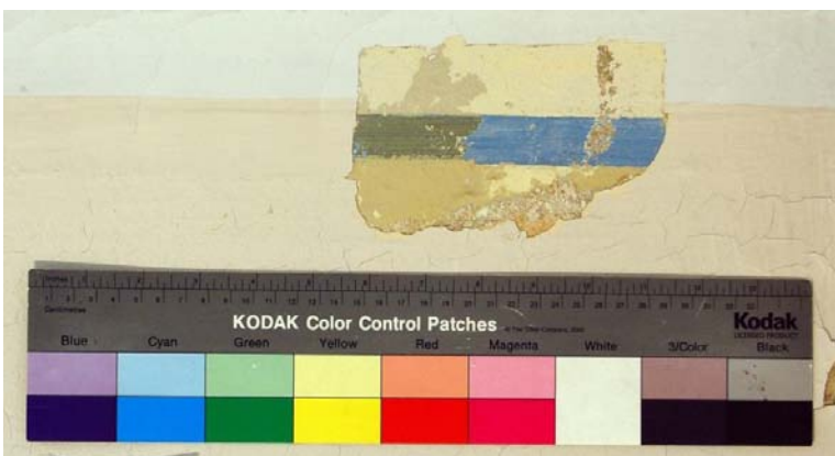
Ikkunaseinän (eteläseinä) katonrajassa oleva esiinotto 3 toisesta ja kolmannelta kerroksesta, jotka sijoittuvat arviolta 1930–40-luvuille. Kerroksista ei reunaanauhojen lisäksi löytynyt muita koristemaalauksia.
