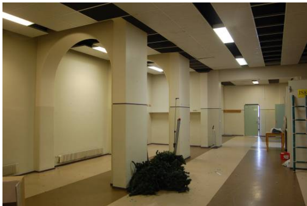
Kuva 46. Aulan keskiosassa on aiemmin ollut vanhan ja uuden puolen yhdistävä käytävä sekä luokkahuone. (Myyrä 2012)
