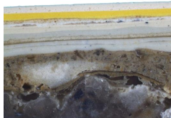
Poikkileikkausnäytteessä 1 erottuvat seinän maalikerrokset 1–6 (alhaalta ylös).
