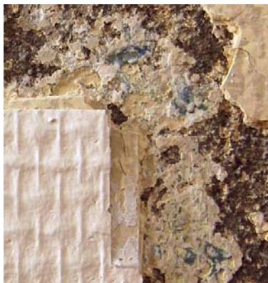
Kuva 92. Luokan 311 seinässä rappauksen päällä on sinistä ja vihreää väriä vaalealla pohjalla. (Myyrä 2012)
