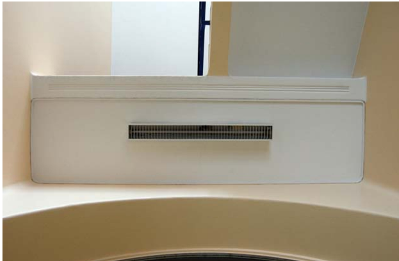
Kuva 5. Uuden puolen porraskäytävän tasanteen katon sekä kaarevan sisäänkäynnin muotoilua. (Myyrä 2012)
