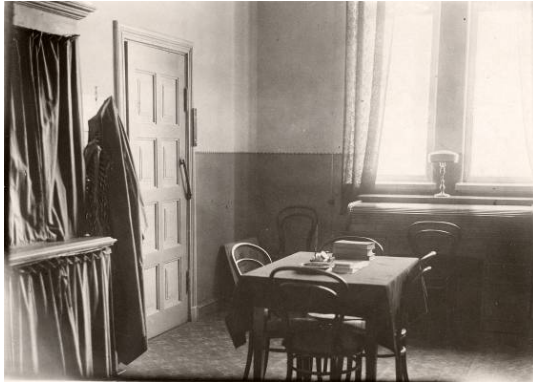
Kuva 15. Opettajienhuoneesta otetussa valokuvassa näkyy seinäpinnan rajausta yläosan vaaleaan ja alaosaan tummaan sävyyn. Rajapintaa on korostettu yksinkertaisella palkkinauhalla. (Etelä-Karjalan museo)
