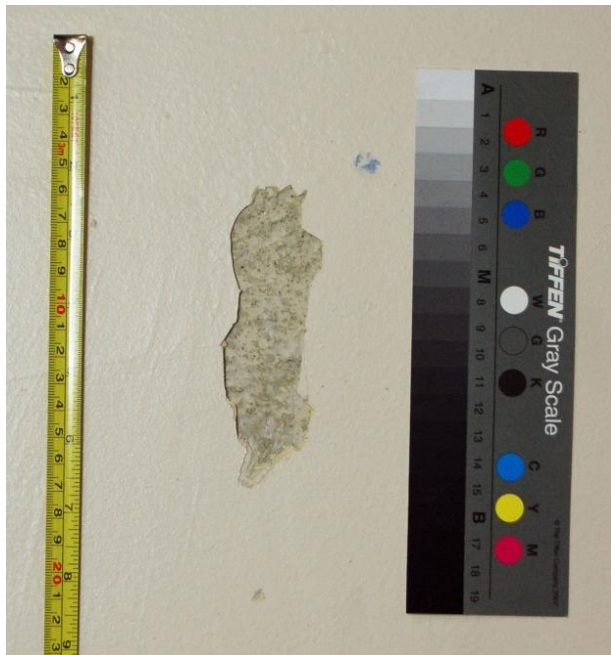
Yläseinässä alin kerros on vihertävän harmaa maali maalattuna suoraan rappauspinnalle.
