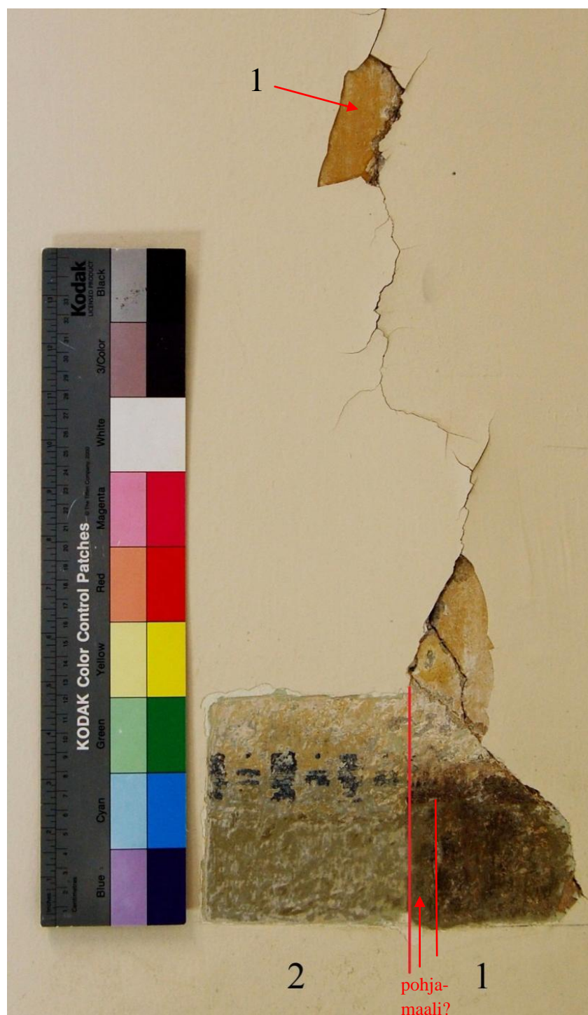
Esilleotto kerroksista 1 ja 2. Kerrosten välissä oleva ohut harmaan vihreä kerros on todennäköisesti pohjamaalia.
