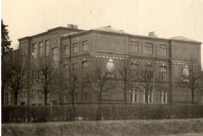
Kuva 6. Lyseo kuvattuna 1950-luvulla toisen laajennuksen jälkeen. Katon tornikoristeet Lönnrotinkadun julkisivussa ovat hävinneet. (Etelä-Karjalan museo)
