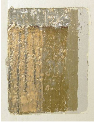
Kuva 62. Eteistilan 101 esiinotto ala- ja yläseinän rajasta. Vasemmalta oikealle kerrokset 1–4. (Myyrä 2012)
