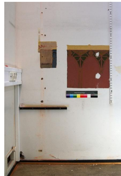
Esilleotot sijaitsevat lähellä ikkunanurkkaa; ala- ja yläseinää erottava paneeliraja kulkee molemmissa kerroksissa 1,3 m korkeudella lattiasta.
