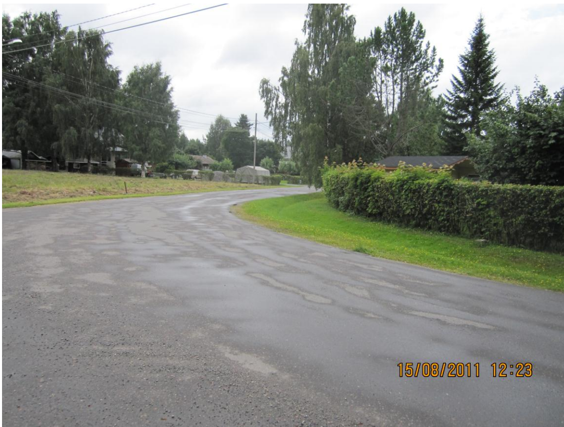
Kuva 15. Verkkotien vesihuoltosaneeraus aloitetaan Verkkotien ja Onkitien risteyksestä (Otto Kaarto 15.8.2011).
