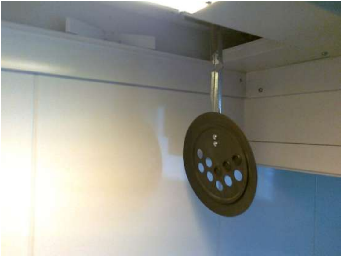
KUVA 15. Premium-liesikuvun sulkupellin säätäminen
