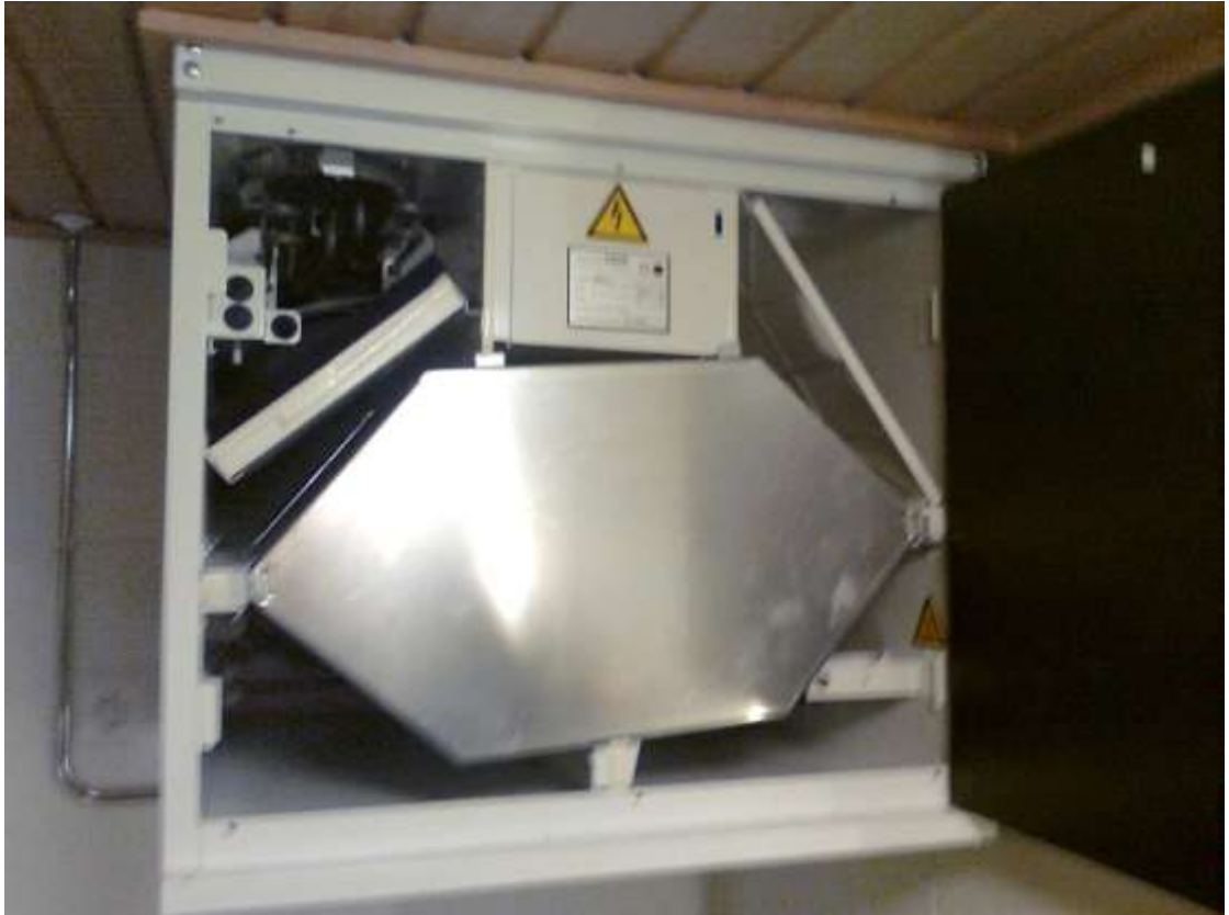
KUVA 5. Swegon W80-lämmöntalteenottokone asennettuna
