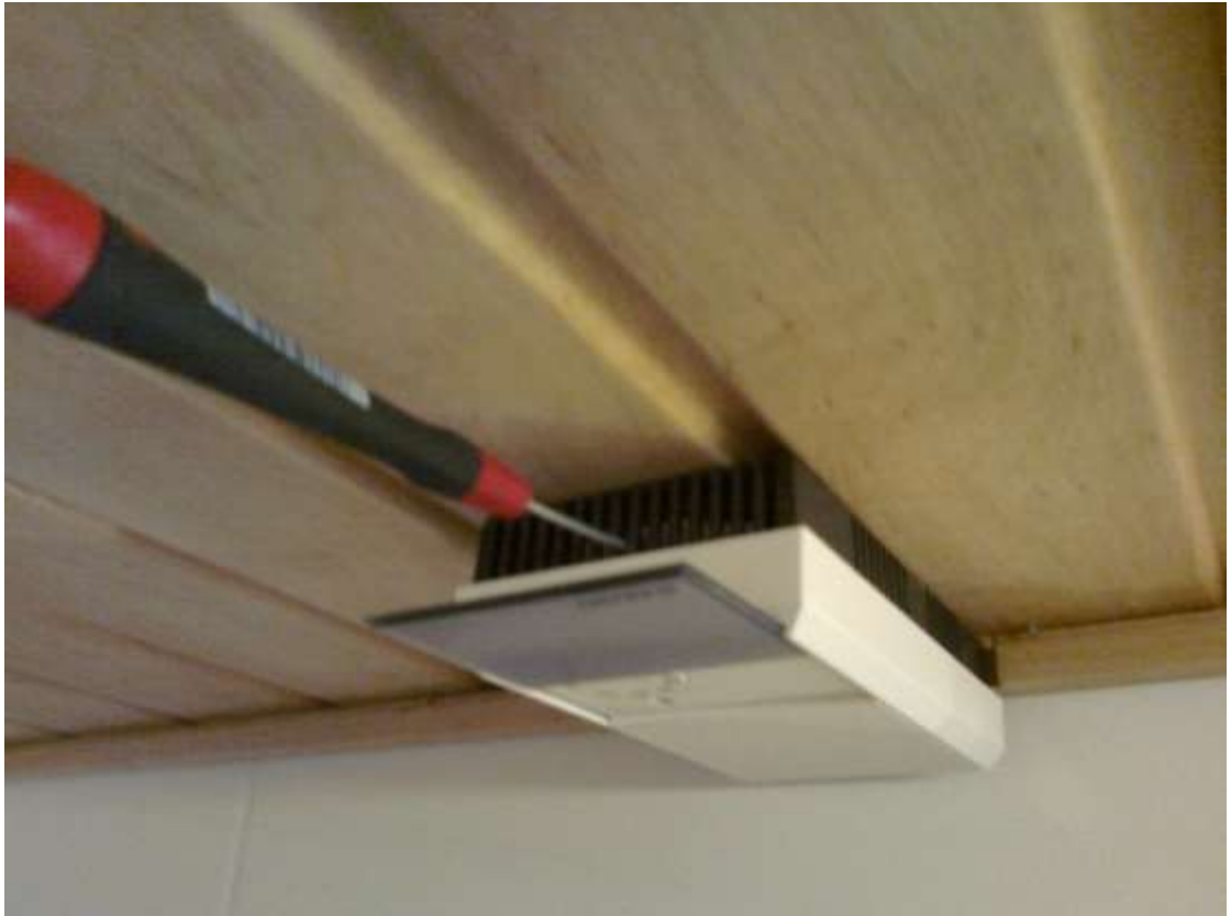
KUVA 18. Kosteusanturin kalibrointi
