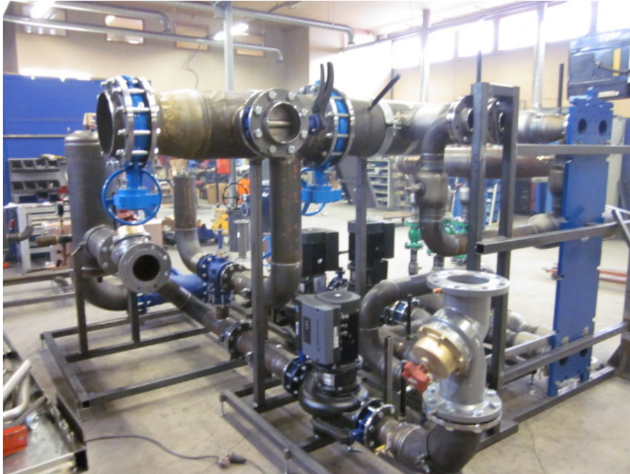
Kuva 14. Kuvan 13 kaukoenergiakeskus valmistuksessa.
