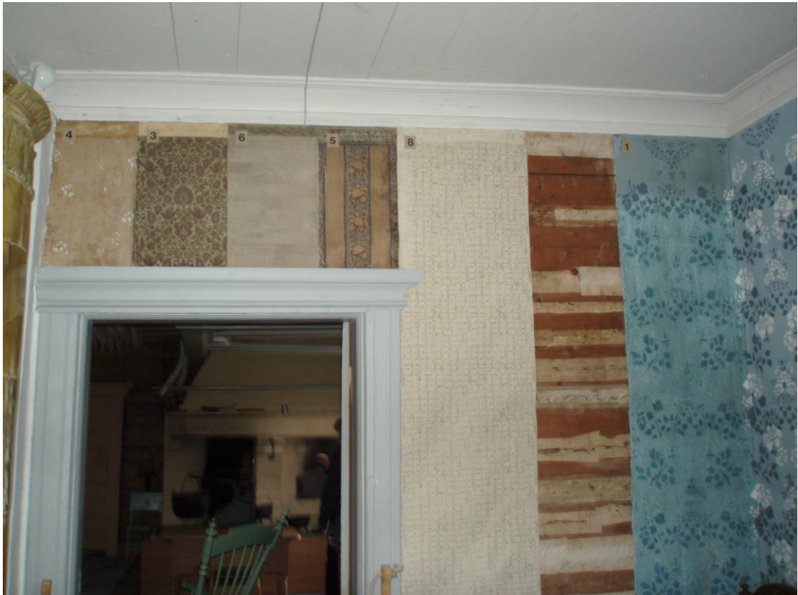
Kuva 7. Yli-Lauroselan museossa on esitetty kaikkia tapettikerroksia. Ensimmäisestä kerroksesta on tehty oikeaan seinään kopio (Lähde: Soljanik 2010).
