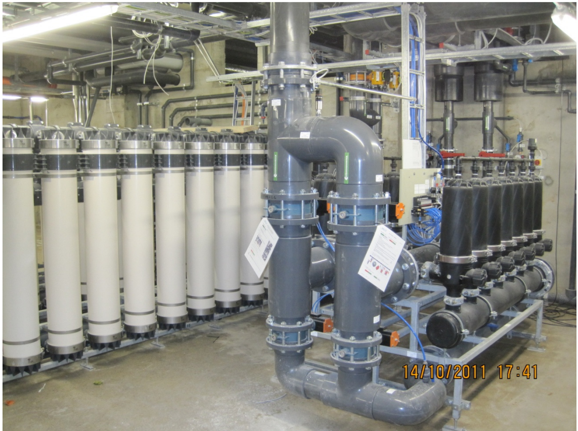
Kuva 24. Valkoiset suodatuspöntöt 9 x 3 kpl ja mustat esisuodattimet Saimaan kylpylässä (10)
