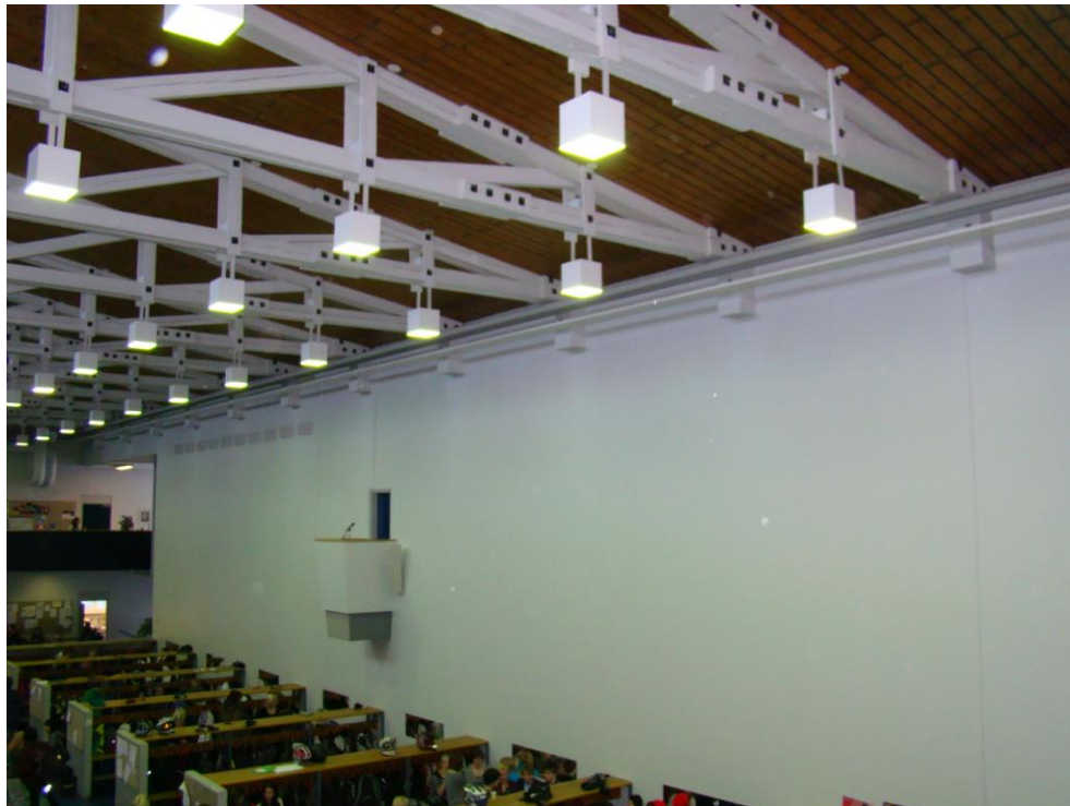
Kuva 16. Kuvattuna näyttävät kattoparrut ja katon materiaalia. (Vuorikoski, 2012)
