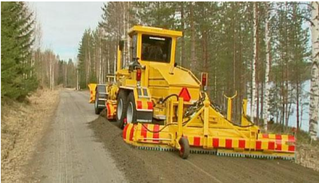
KUVA 6. Soratien kunnostamista tiehöylällä (MTV3 45 minuuttia. 2012)
