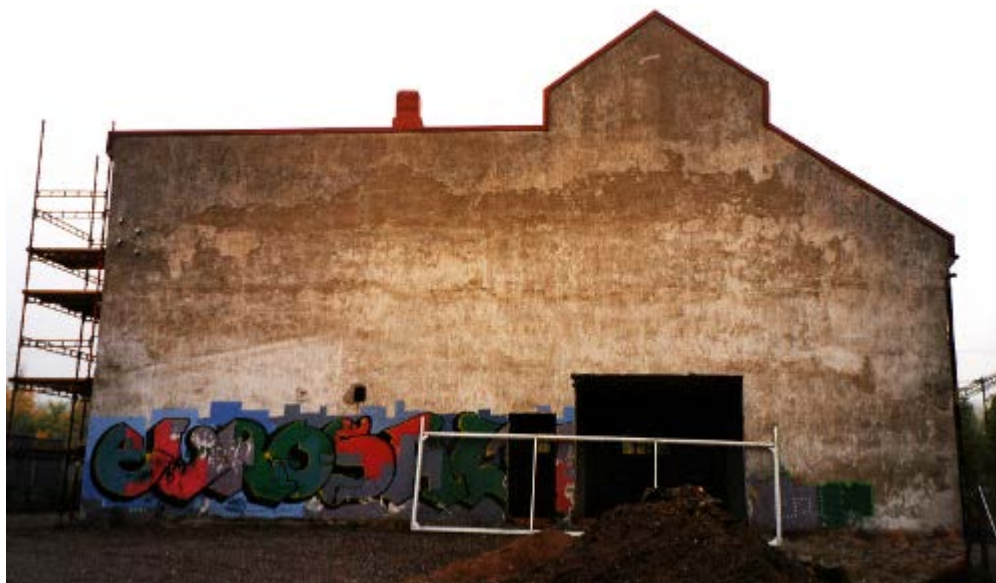
Kuva 13. Moisionkadun rakennus ennen remonttia
