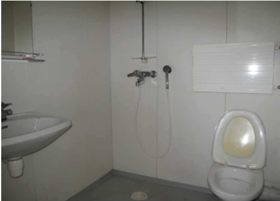
Kuva 13. Kylpyhuone ennen viihtyvyysskorjausta. (Hoasin ottama kuva)
