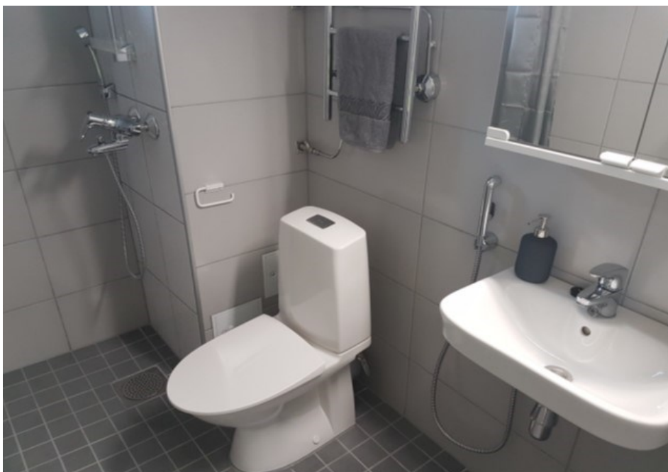
Kuva 14. Kylpyhuone remontin jälkeen. (Hoasin ottama kuva)
