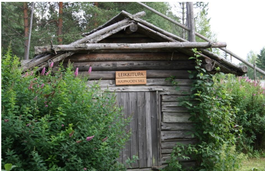
Kuva 27. Lasten aitta, pikku aitta, vuonna 2011. Kuva Johanna Kallenautio.
