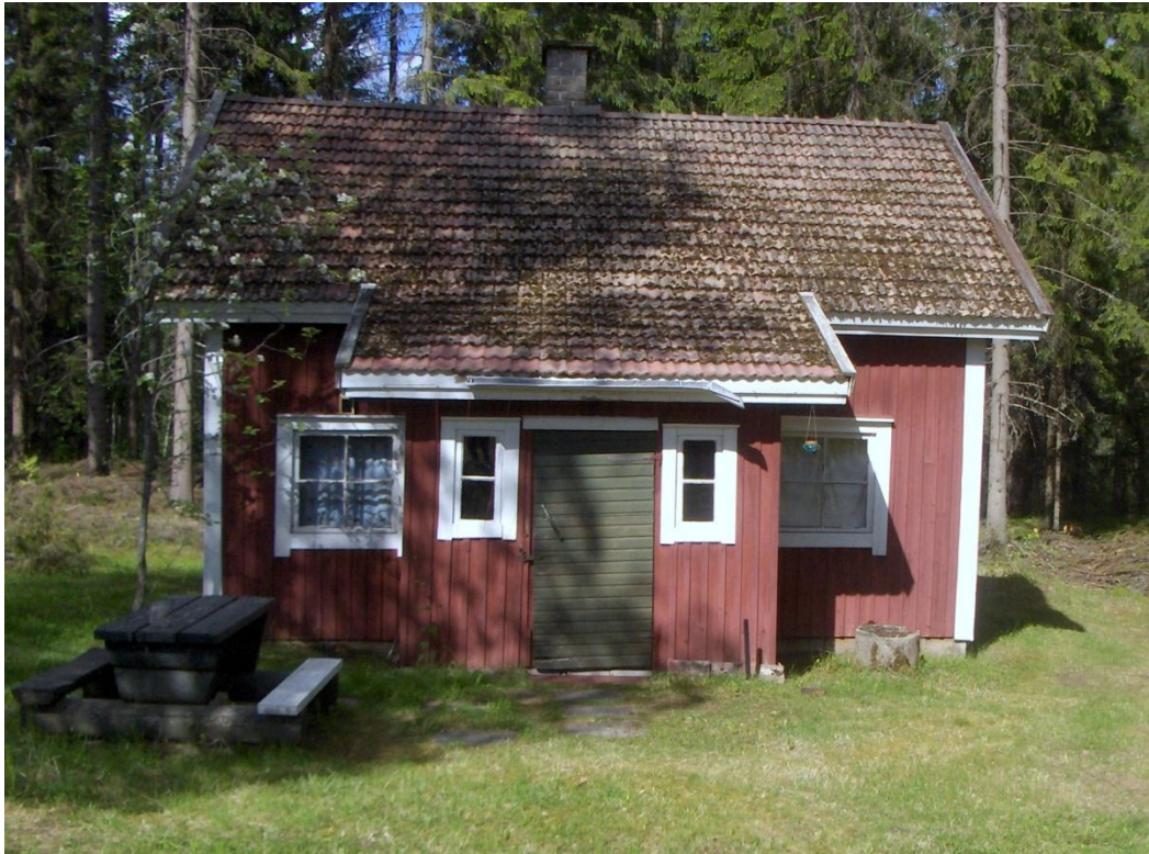
Kuva 30. Kallenaution tilan vanha sauna. Kuva Johanna Kallenautio 2010.
