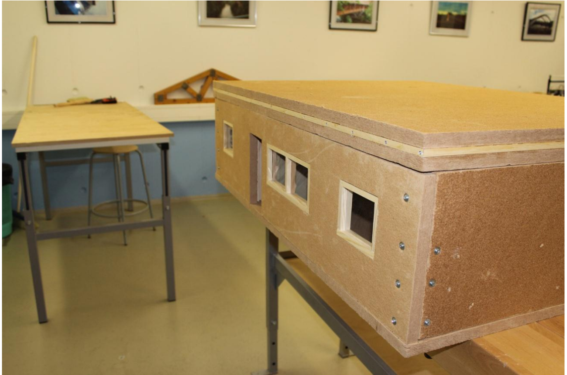
Kuva 11. Ulkoseinien ruuviliitos
