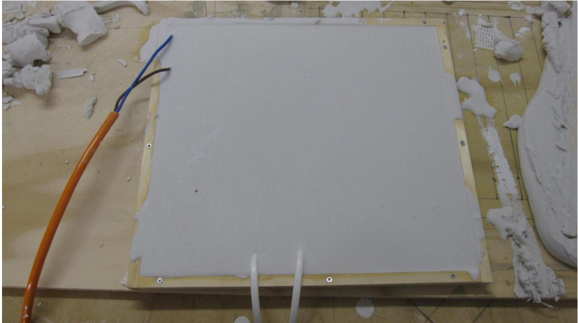
Kuva 10. Makuuhuoneen valettu lattia, huomaa antureiden johdot
