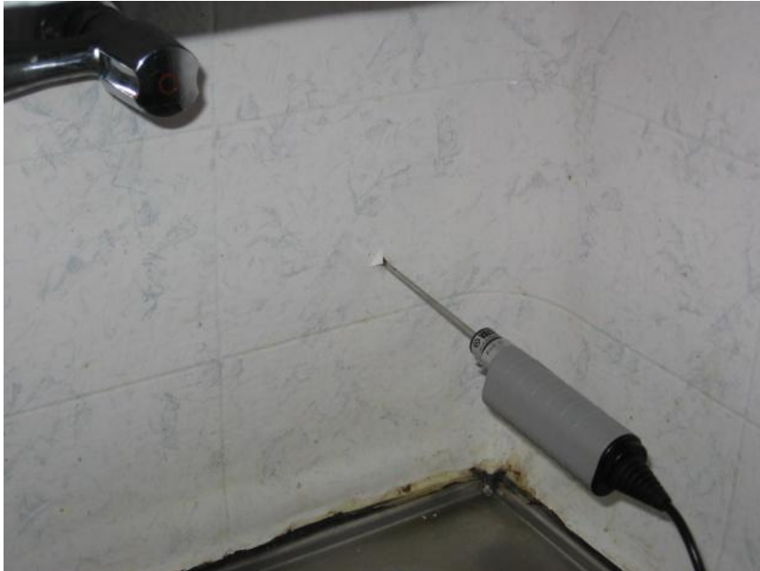
Kuva 7. Kosteusmittaus tiskialtaan yläpuoleisen väliseinän eristetilasta.
