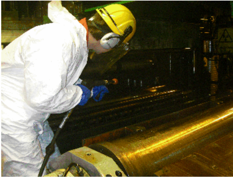
Kuva 40. 1-puolen sivuohjurialueen pesu öljypainepesurilla
