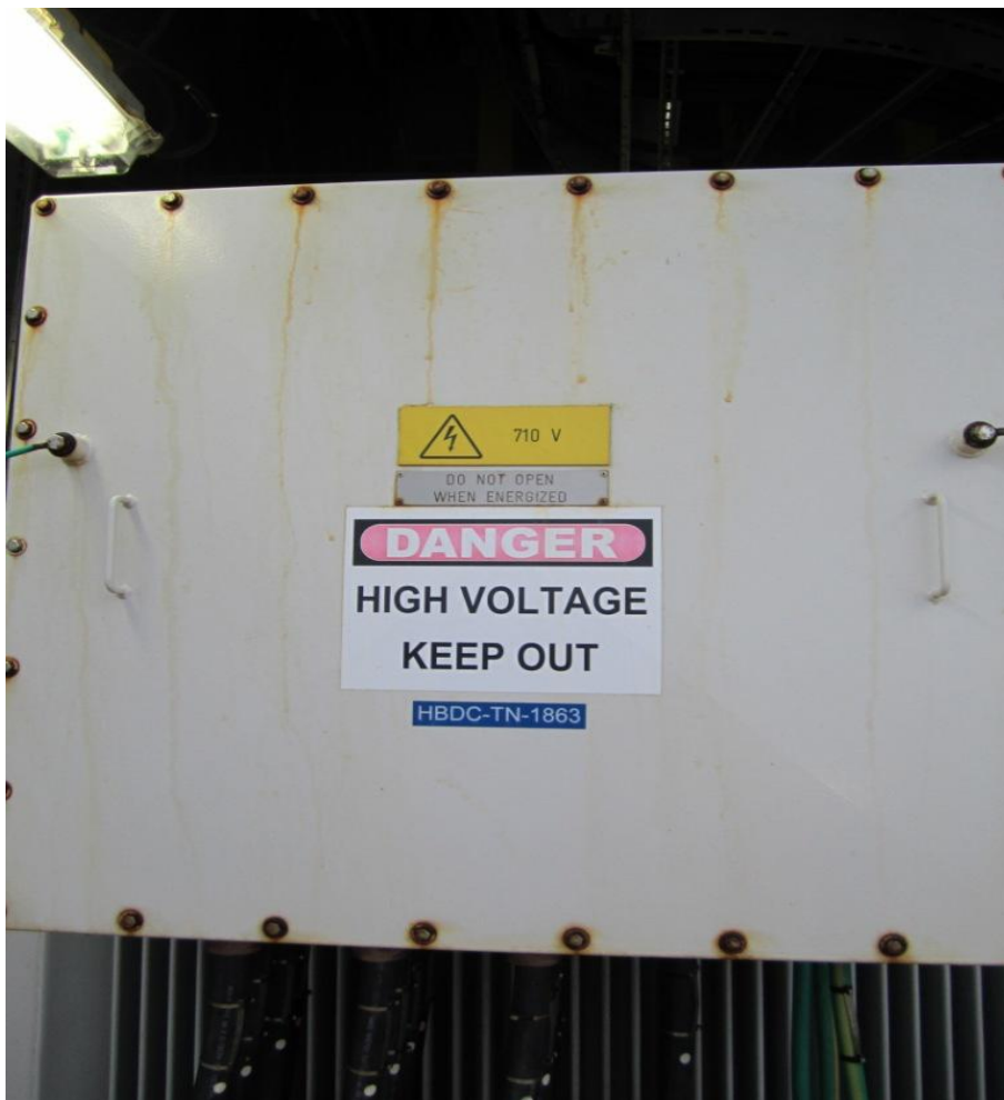
Kuva 6. Galvaanista korroosiota kotelon kiinnitysosissa
