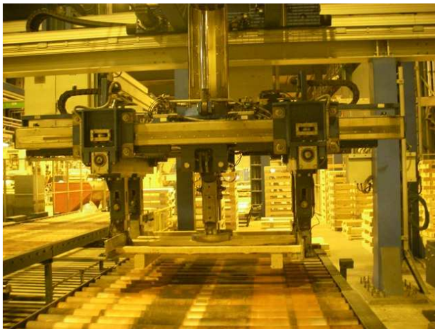
Kuva 17. Lavausroboti Veijo laskemassa lavaa rullaradalle
