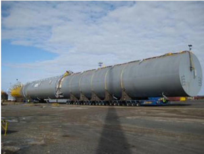
Kuva 2. Tuulivoimalan jalan siirto SPMT-akselistolla, pituus on 120m ja massa 1600t.
