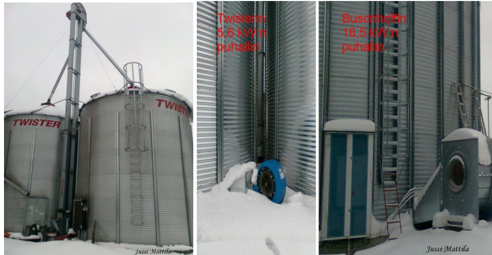
Kuva 5, Tuuletuspohjallisia siiloja (Mattila, 2012). Kuva 6 ja 7, Twisterin ja Buschhoffin puhallimet (Mattila, 2012)
