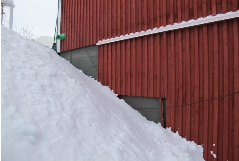
KUVIO 14. Julkisivuverhous rakennuksen kaakkoispäädyssä
