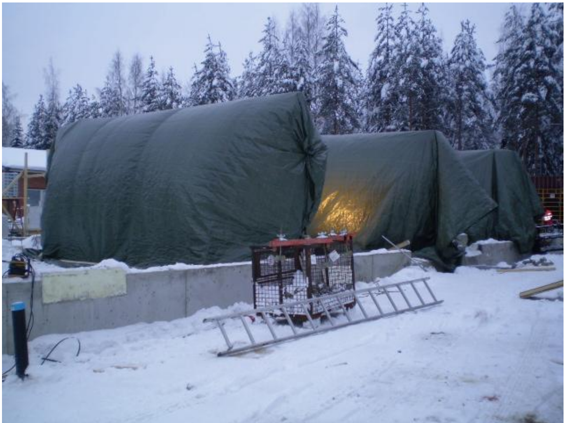
Kuva 7 Muotit ja valetut seinät suojattuna
