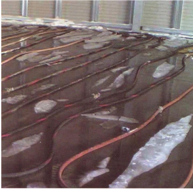
Kuva 3 Glykoliputkisto
