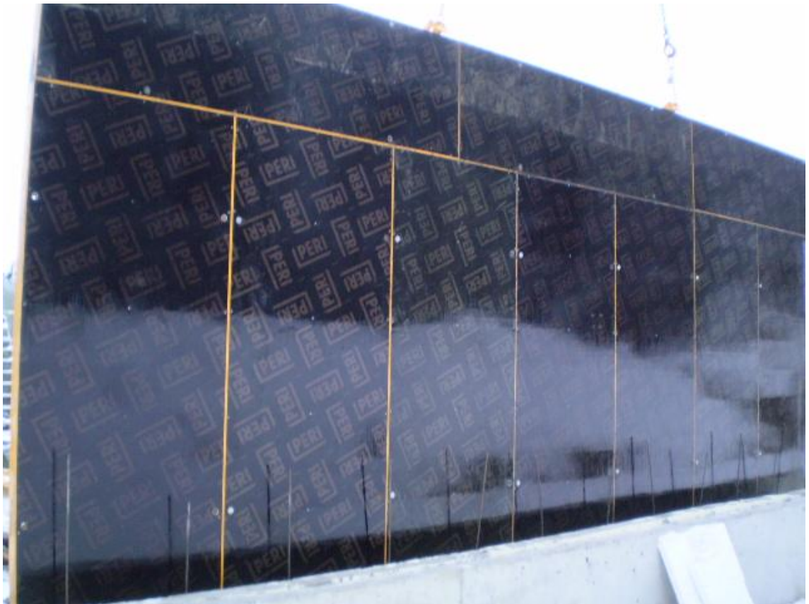
Kuva 5 Kasettimuotti paikalleen nostettuna ja öljyttynä.
