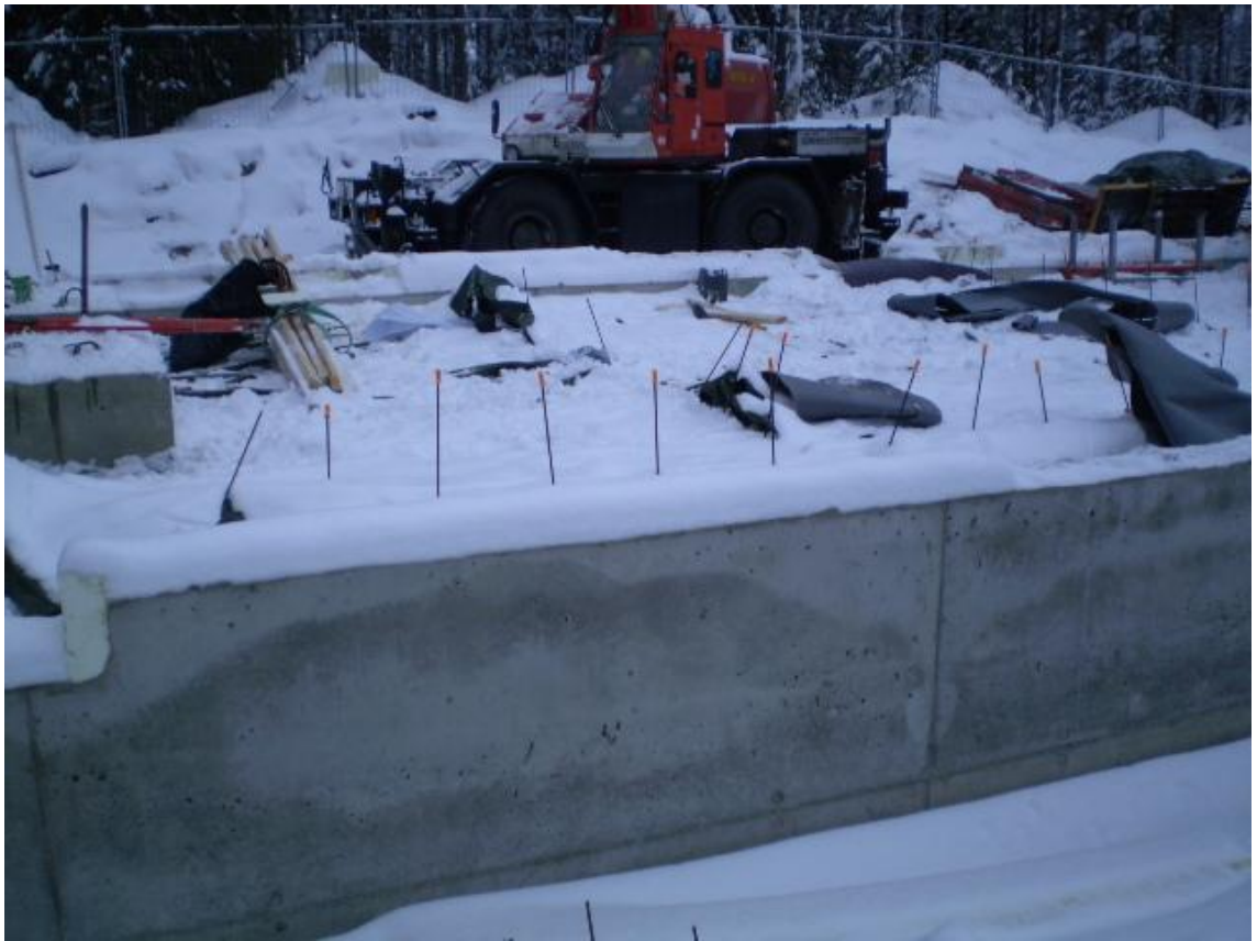
Kuva 2 Alapohja suojattuna ja lumenpeitossa
