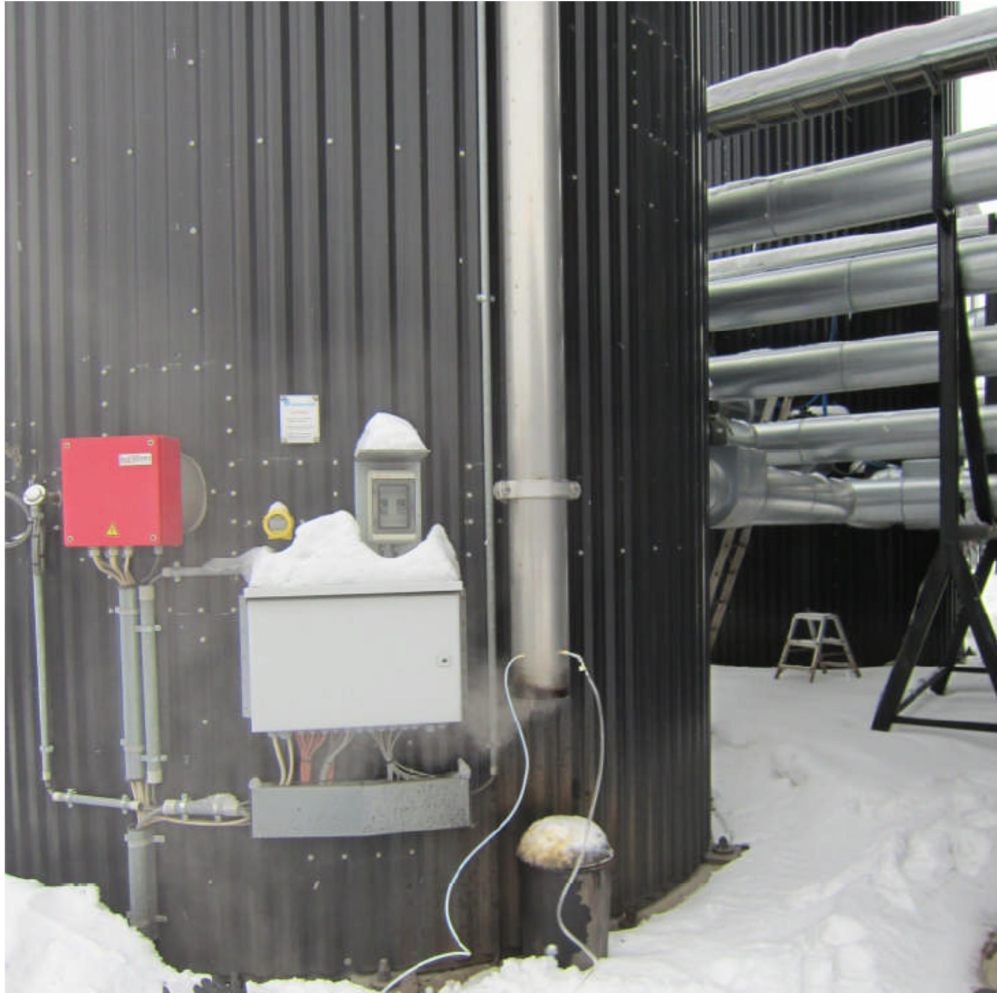
KUVIO 8. Bitumisäiliön hönkäkaasujen mittaus käynnissä.
