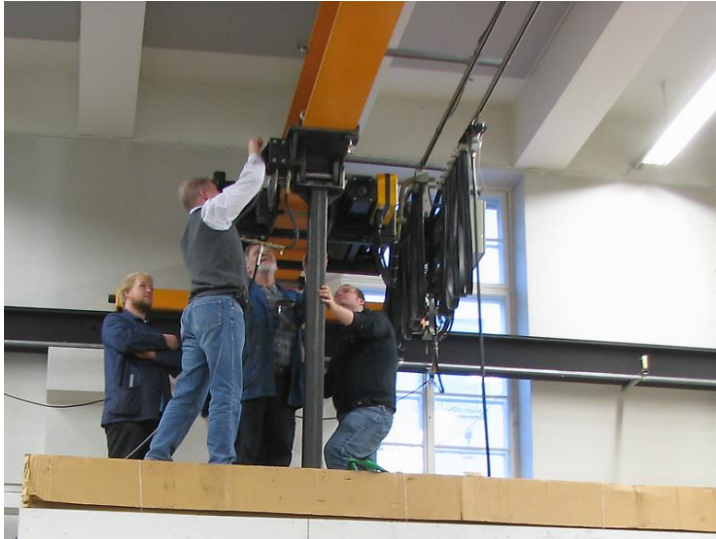
Kuvio 39. Vasaran asennus siltanosturin palkkiin.
