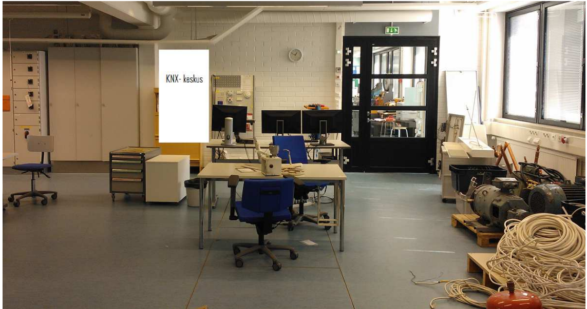
Kuva 2. KNX-keskuksen sijoittuminen laboratoriossa.
