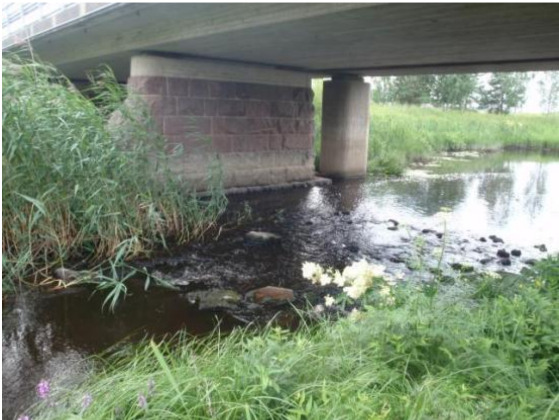
Kuva 4. Kustavintien virtapaikka kuvattuna maantiesillan kohdalta.
