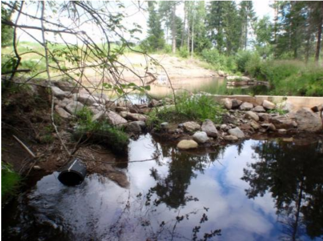
Kuva 54. Kaivettu lampi ja patorakenne Kasulan kohdalla Raasinjoessa. Kuva: Sasu Kukkonen.
