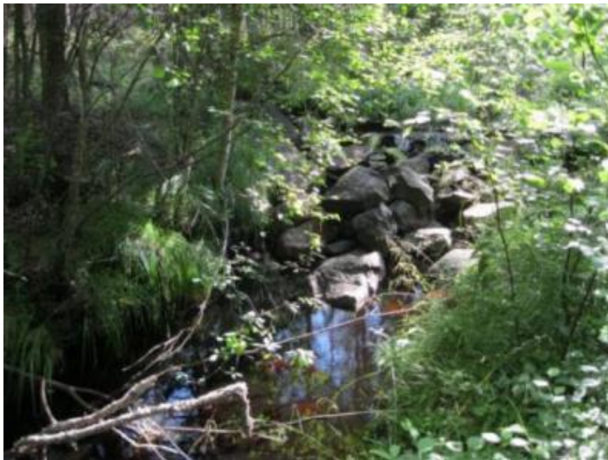
Kuva 51. Kivillä tuettu pato Mynäjärven luusuassa. Kuva: Sasu Kukkonen.
