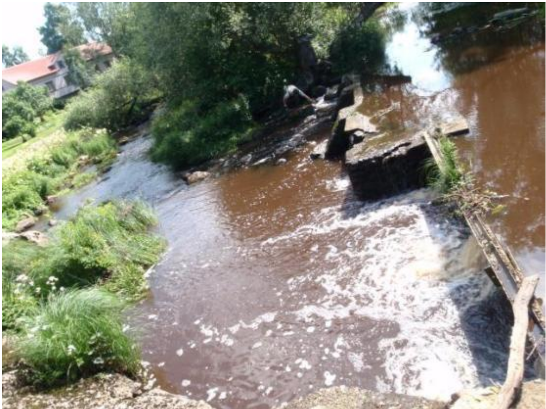
Kuva 11. Raimelankosken niskalla sijaitseva pato.
