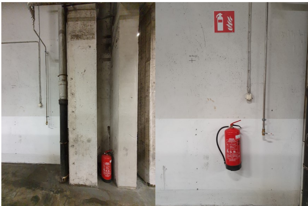
Kuva 7. Palosammuttimen paikka ennen ja jälkeen
