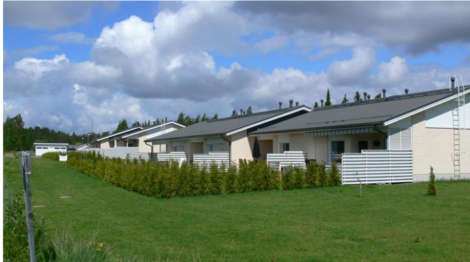
Kuva 2. As. Oy Pappilanrinne, Masku (Rakennusurakointi S. Tikakoski Oy 2012).
