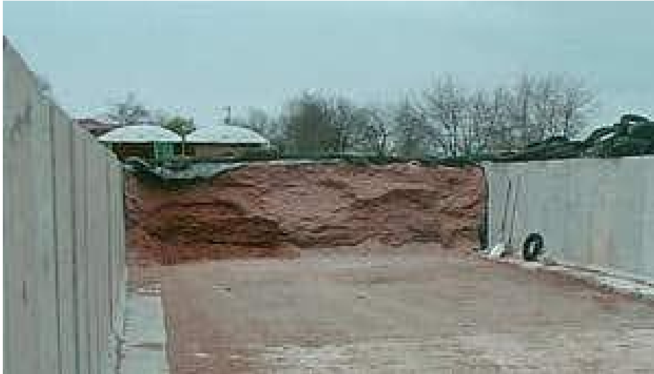
KUVIO 3. Betonista rakennettu laakasiilo (Kangas 2006)
