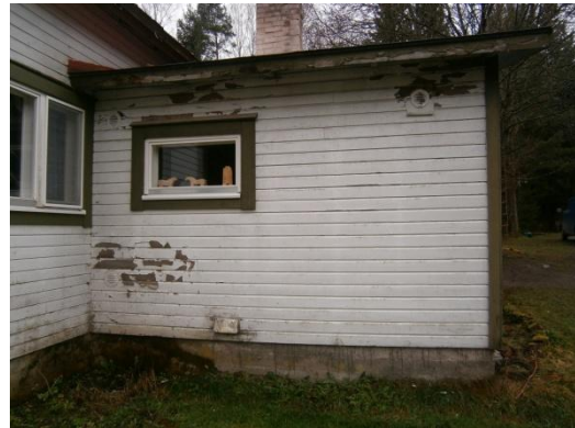
KUVA 10. Saunan toinen ulkoseinä.
