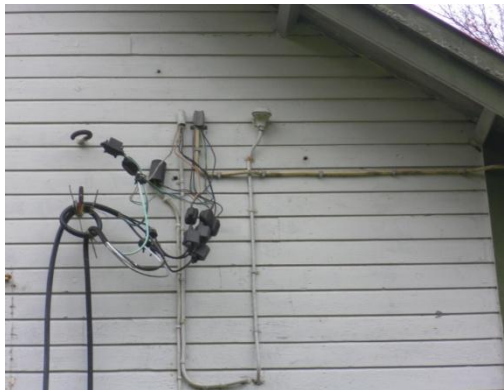
KUVA 9. Sähköjohdot talon ulkoseinässä.
