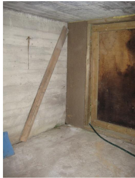
KUVA21. Takaseinä ja ovi.
