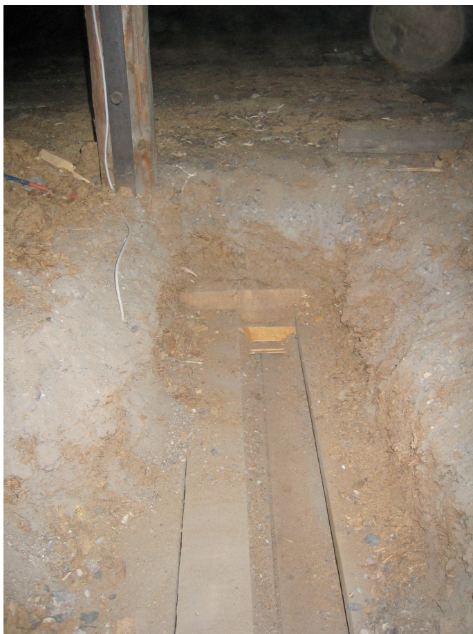
Kuva 17. Yläpohjan eristeet poistettu (Niinikoski 2012a.)
