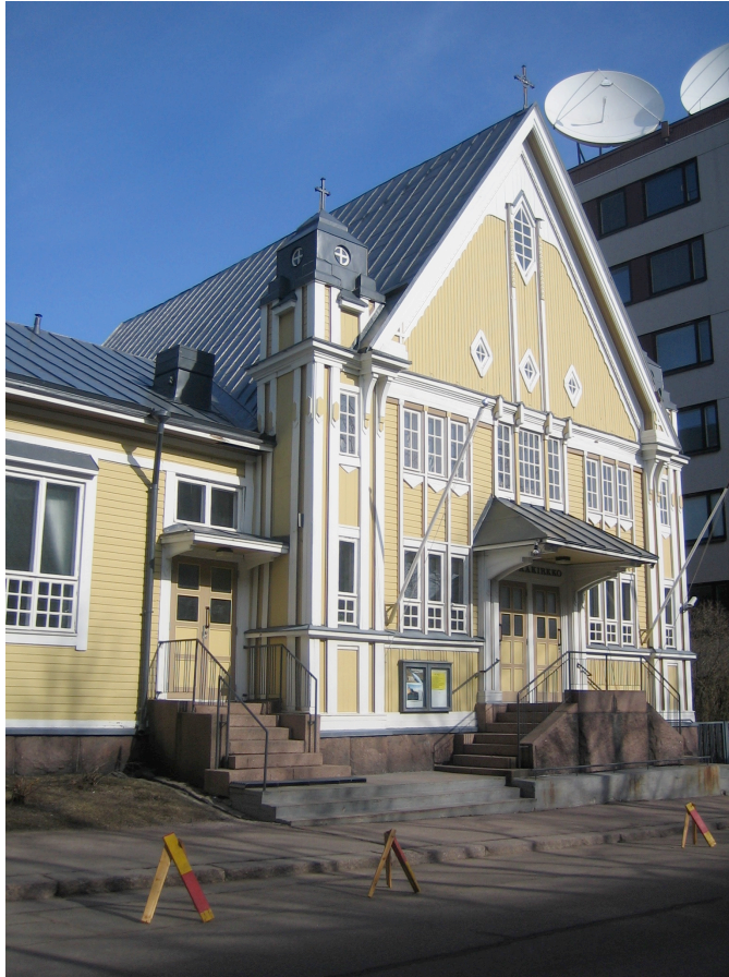
Kuva 6. Mariankadun puoleinen julkisivu (Niinikoski 2012b.)
