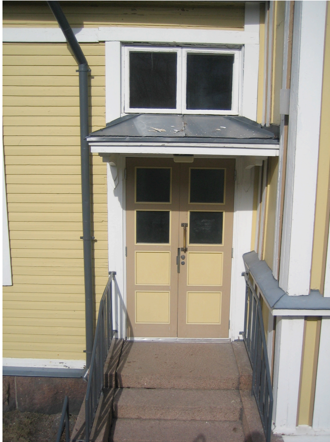
Kuva 10. Seinärakenne on pahasti vaurioitunut ikkunoiden yläpuolelta. Kyseiset ikkunat ovat tarkoitus poistaa. (Niinikoski 2012b.)
