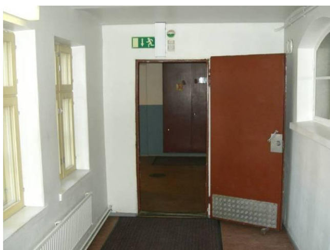
Kuva 1: Suljetulle pohjoispää 1 ja 2 osastolle johtava väliovi
