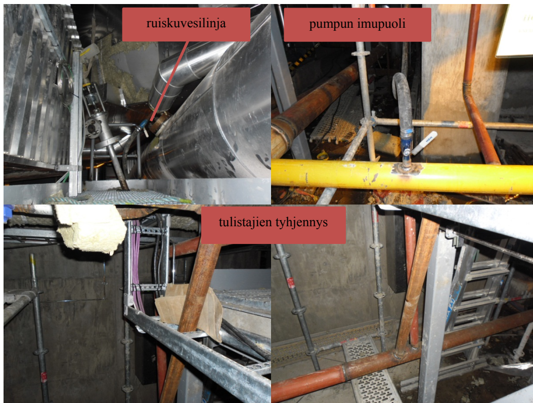
Kuva 27. Kaasukattilan ruiskutusvesilinjojen ja tulistajien kytkennät
