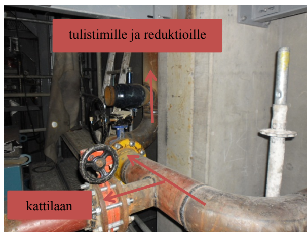
Kuva 34. Peittauksen aikainen kytkentä
