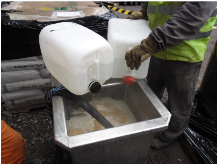
Kuva 22. Boilex- hapenpoistokemikaalin annostelu ja pH:n säätö
