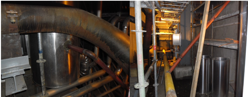
Kuva 26. Kattilan tyhjennysputket
