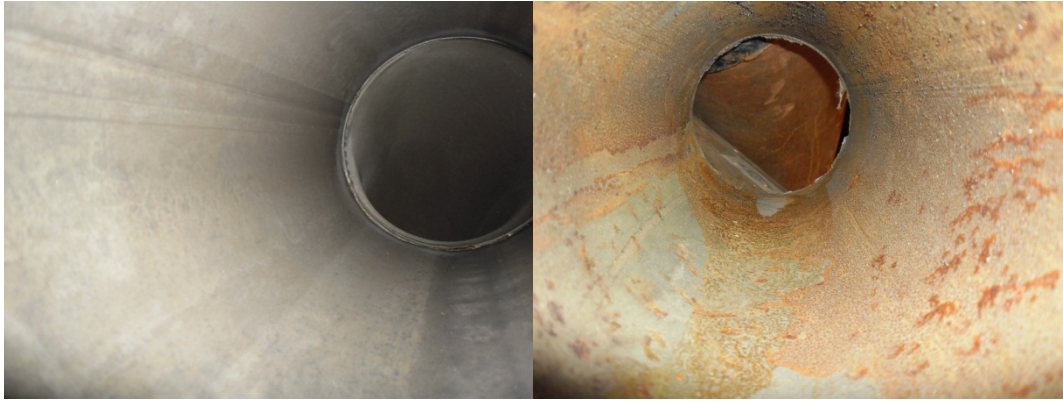
Kuva 36. Peitattu ja peittaamaton putki
