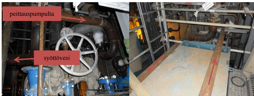
Kuva 28. Syöttövesipumpun kytkennät
