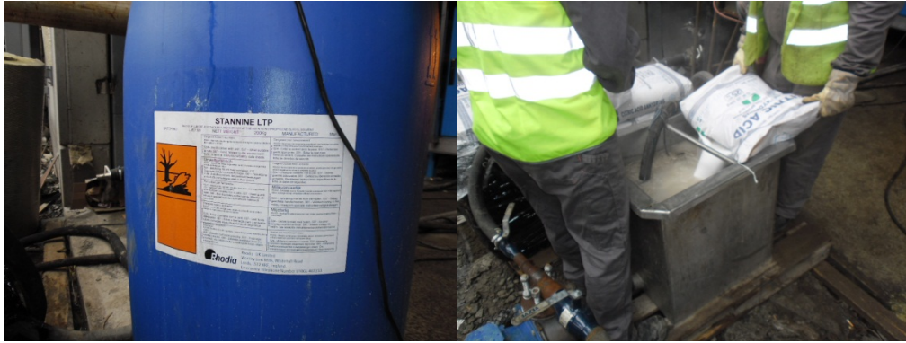
Kuva 11. Inhibiittorin ja sitruunahapon annostelu
