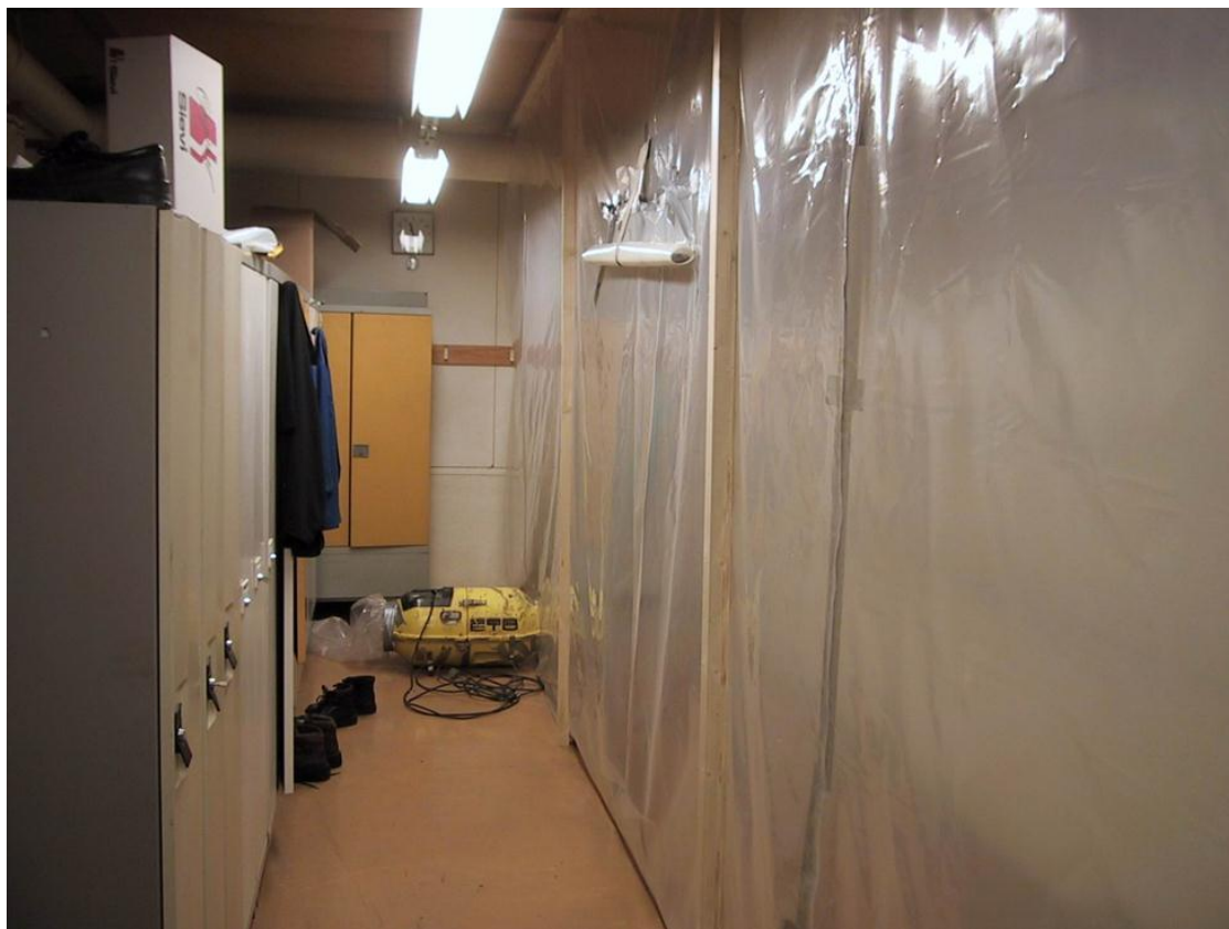
Kuva 11. Osastointi asbestin purkua varten (Lönnblad 2011.)
