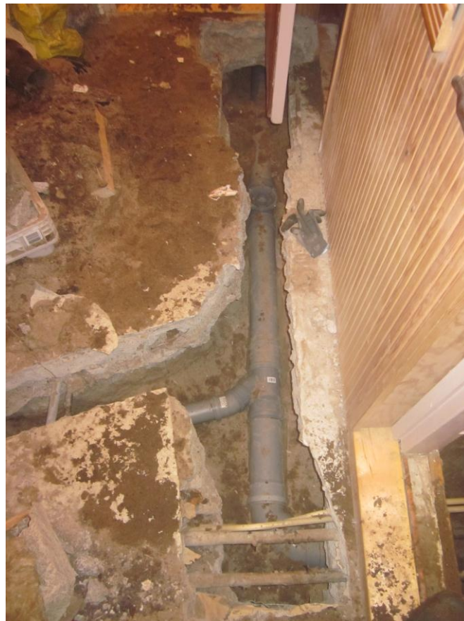
Kuva 16 ja 17. Lattiarakenteet on purettu esimerkkikohteessa. (Khanbabaei Khanshan 2012.)
