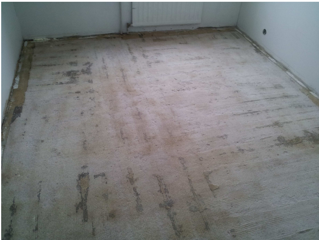
Kuva 7. Huoneen lattia asbestin poistamisen jälkeen.
