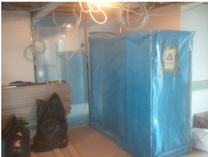
Kuva 4. Osastointi asbestin purkua varten.
