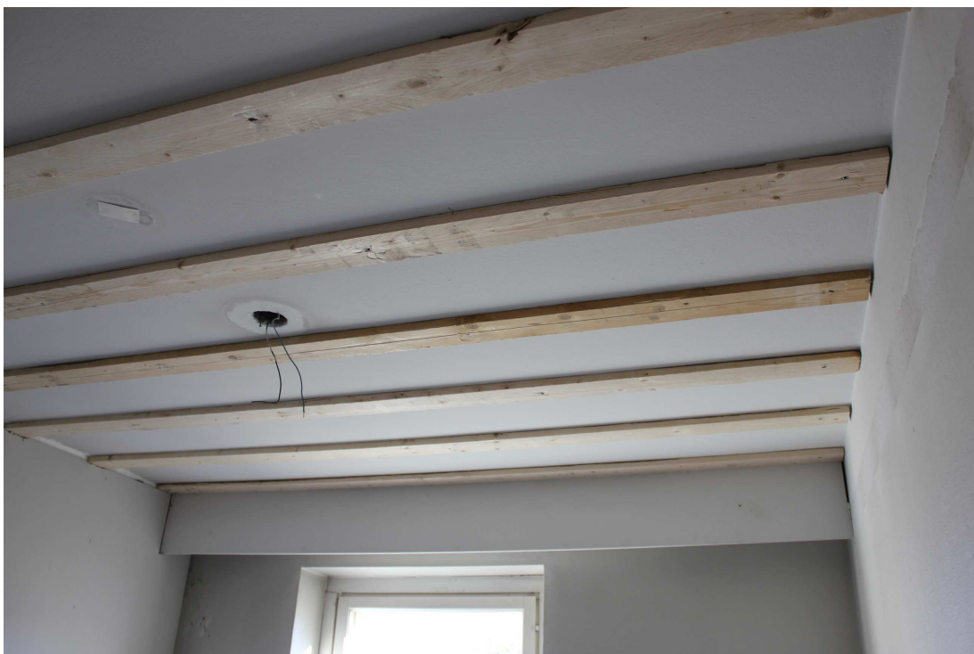
Kuva 9. Huoneen katto koolattuna.
