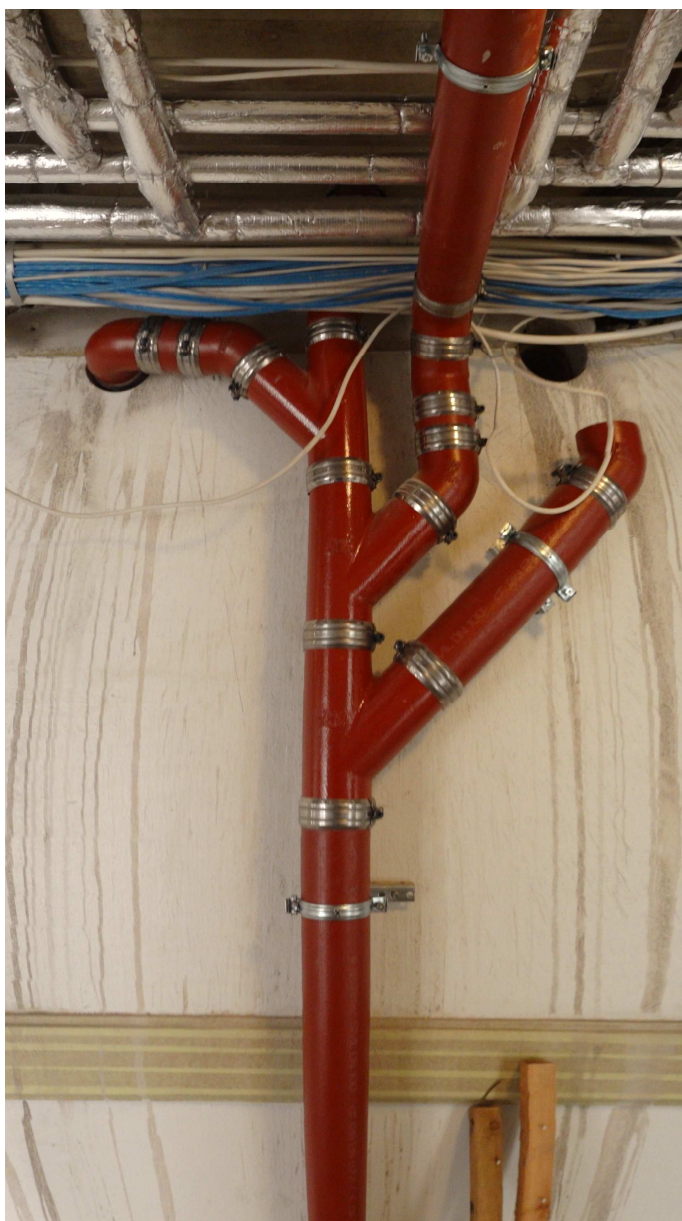
Kuva 10. Uutta viemärilinjaa. Yllä vesiputket eristettyinä.
