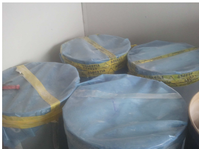
Kuva 3. Asbestijäte säilöttynä kuljetusta varten.
