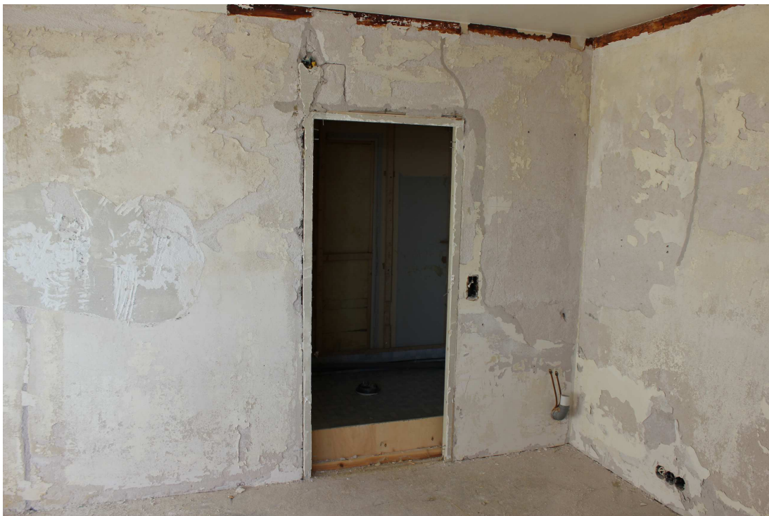
Kuva 8. Seinät tapetin poistamisen jälkeen.
