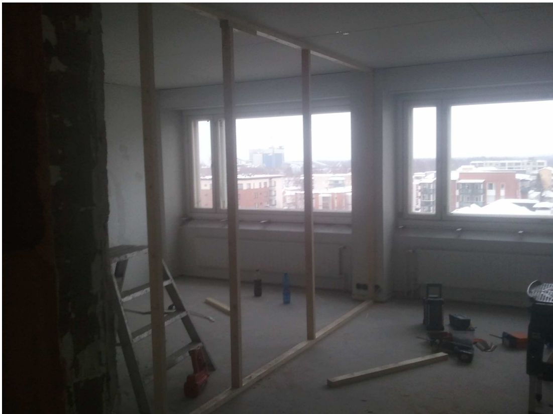
Kuva 6. Saman huoneen ääneneristysseinän ensimmäinen runko alkutekijöissään.
