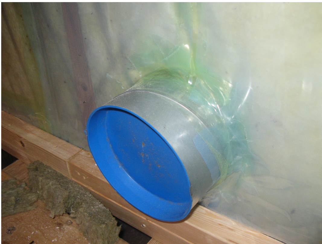
Kuva 11. Ilmastointiputki on tiivistetty teippaamalla.
