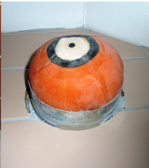
Kuva 6. Kumipallolla tiivistetty ilmastointikanava
