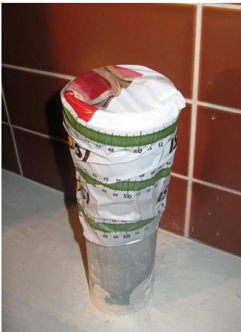
Kuva 5. Teippaamalla tiivistetty viemäriputki
