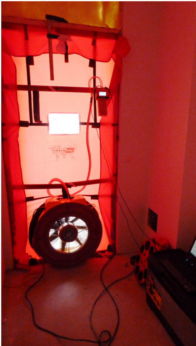
Kuva 8. Mittauslaitteisto asennettu huoneiston ulko-oveen.
