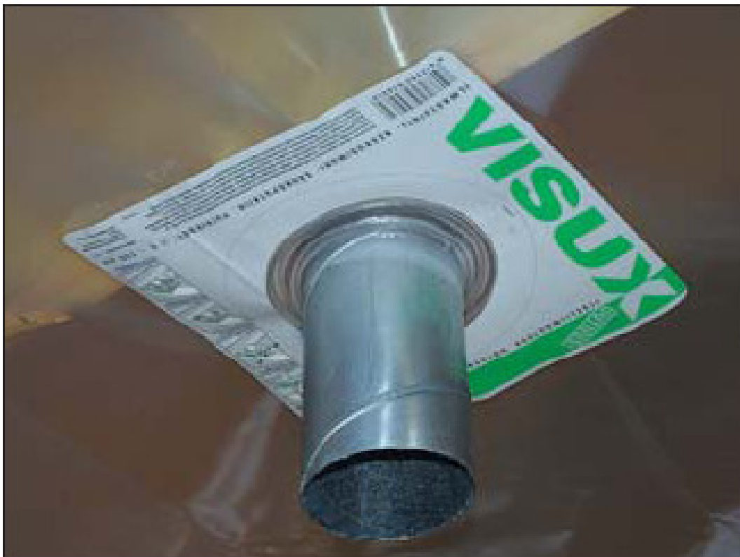
Kuva 12. Ilmastointiputki on tiivistetty teollisesti valmistetulla läpivientikauluksella.
