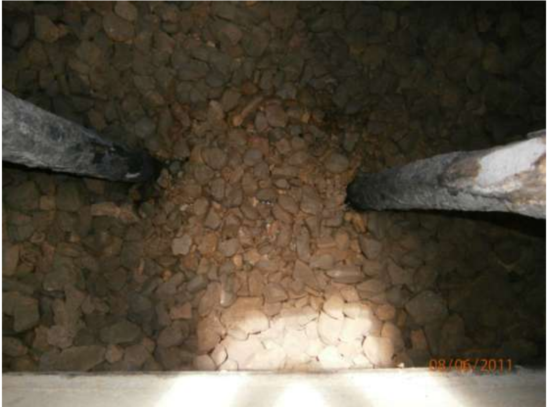
KUVA 9 Filtro de tratamiento - kivistä tehty käsittelysuodatin. (Pietilä 2011)
