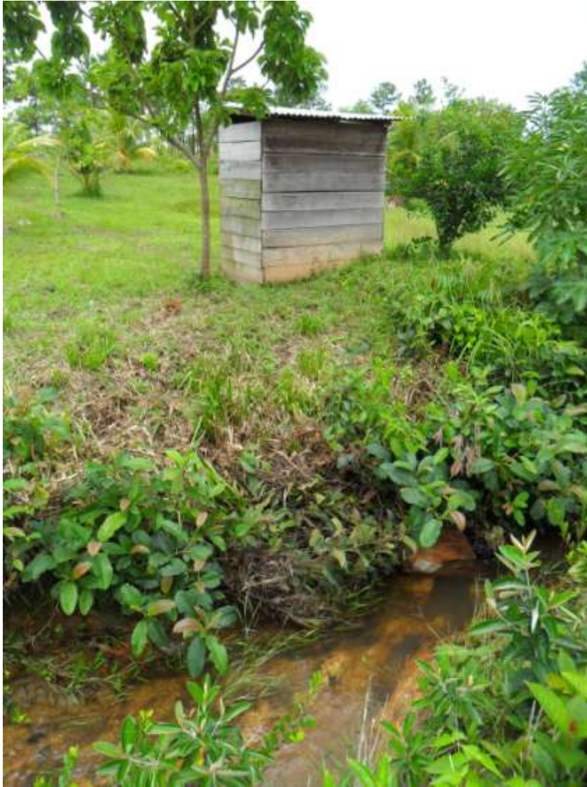
KUVA 38 Huonosti sijoitettu käymälä. Käymälä on rakennettu korkeammalle ja se liian lähelle puroa. (Pietilä 2011)
