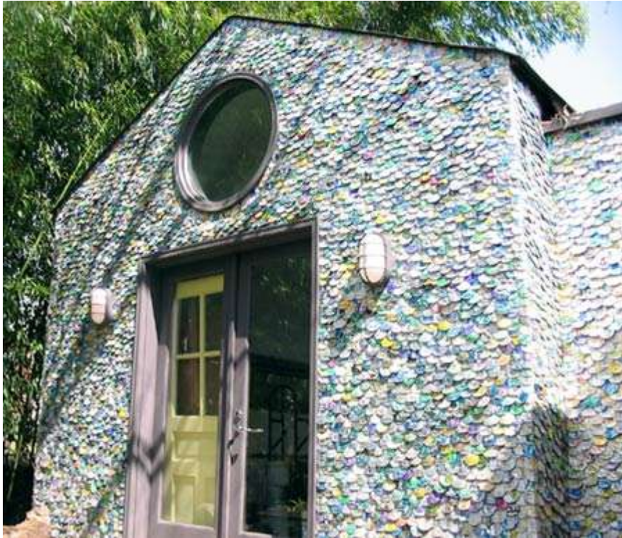
KUVA 43 Alumiinitölkeistä rakennettu talon ulkoseinä. (Recyclingrag 2004.)
