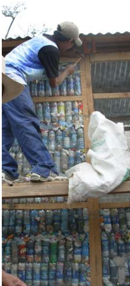
KUVA 47 Pura Vida ekotiiliseinä rakennusvaiheessa. (Puravidatitlan 2012.)
