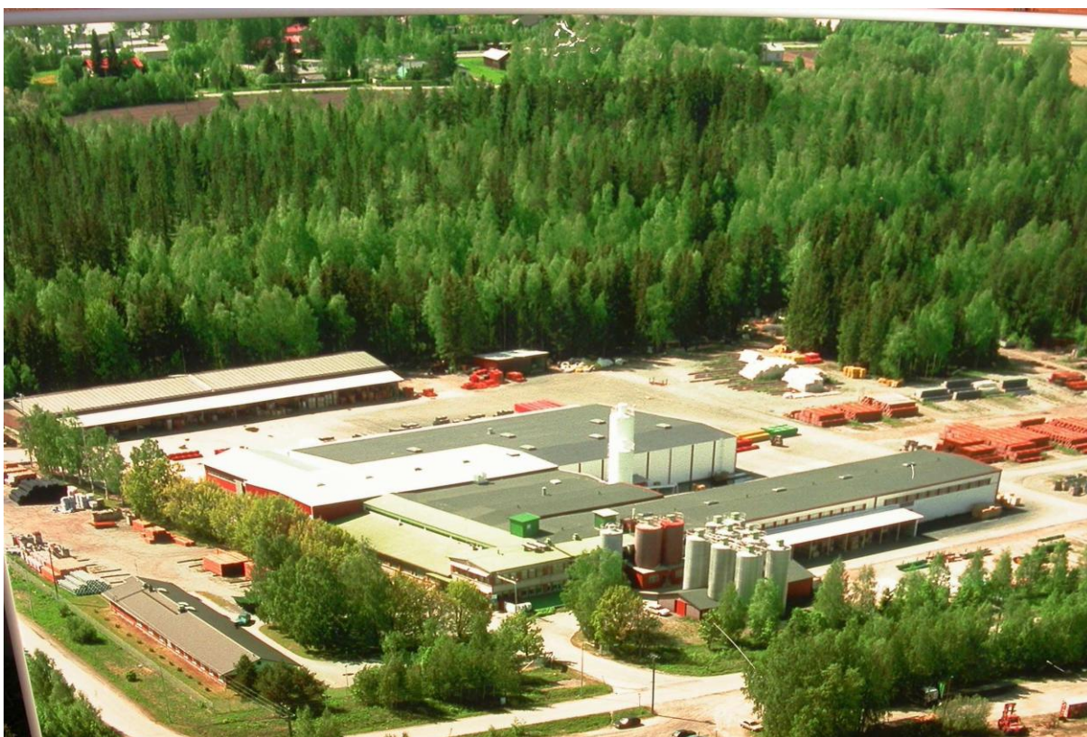
Kuva 1. Oy KWH Pipe Ab:n Ulvilan tehdas
