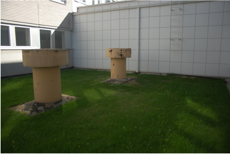
Kuva 9 Pihä-alueella sijaitsee hankalasti keskellä pihaa laitteistoja.
