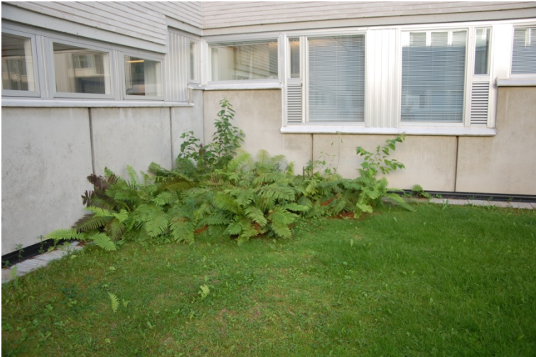
Kuva 23 Kasvillisuus on istutettu paikoittain liian lähelle seinää.
