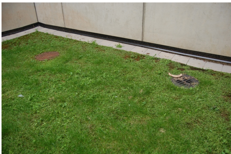
Kuva 13 Sisäpiha-alueella on hyvä sadevesiviemärointi.
