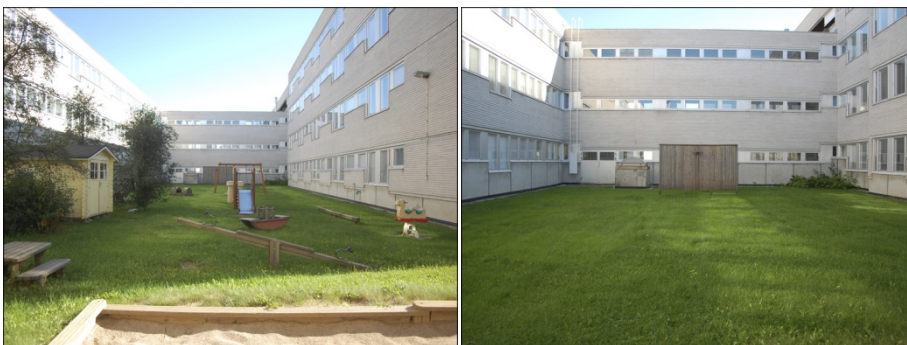
KUVA 2 ja 3. Piha-alueen epämääräistä toimintojen sijoittelua ja turvattomuutta herättävä näkymä kohti etelää.
