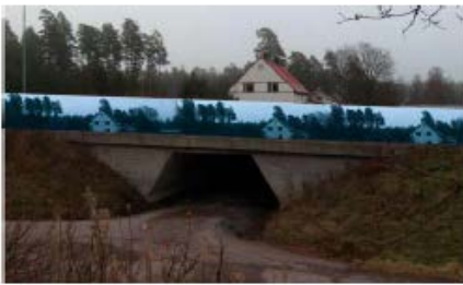
KUVIO 26. Graafinen betoni. (kuva Tuula Lehtinen, Frei Zimmer oy, hakupäivä 11.11.2011)
