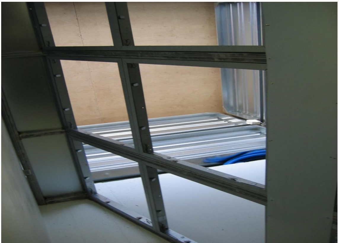
Kuva 4. Raitisilmatornin suodatinseinä, suodattimia ei ole vielä asennettu paikoilleen (kuva Petteri Nurmi).
