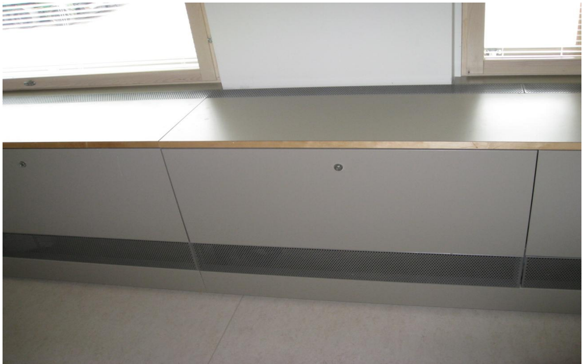
Kuva 9. Luokkahuoneen ikkunapenkki. Ilma virtaa luokkahuoneeseen alaosan säleikön läpi (kuva Petteri Nurmi).
