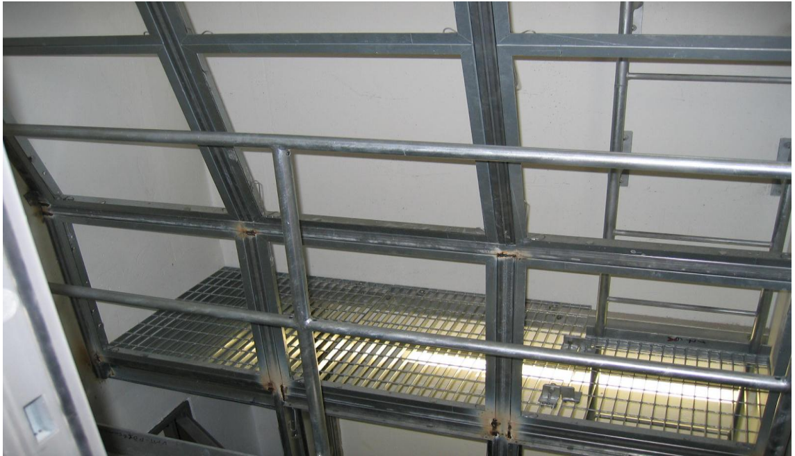
Kuva 3. Raitisilmatornin suodatinseinä, suodattimia ei ole vielä asennettu (kuva Petteri Nurmi).
