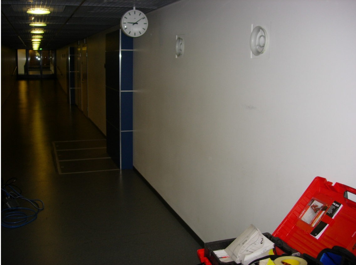
KUVA 20. Oppilaitoksen väestönsuojan seinä
