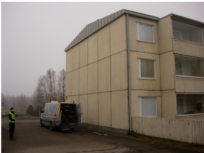
KUVA 15. 1970-luvulla rakennettu kerrostalo
