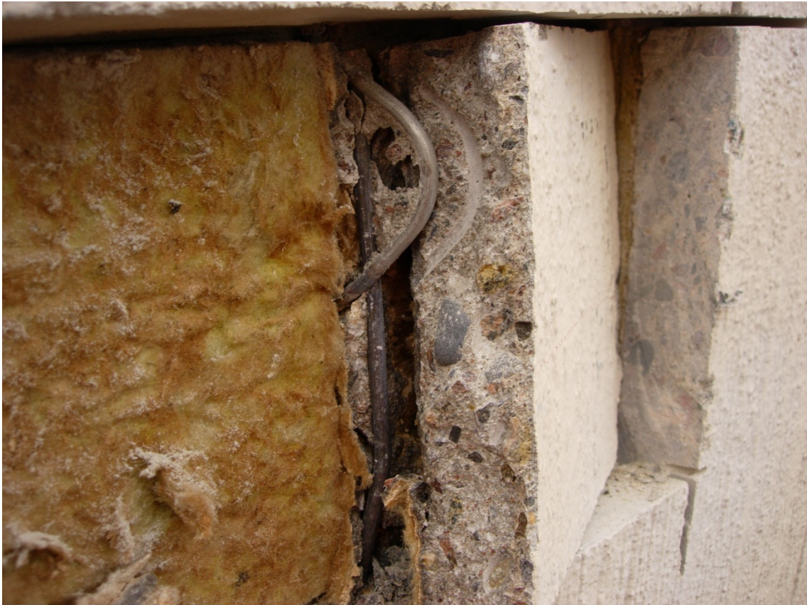
KUVA 18. Näytteenotto sandwich-elementistä
