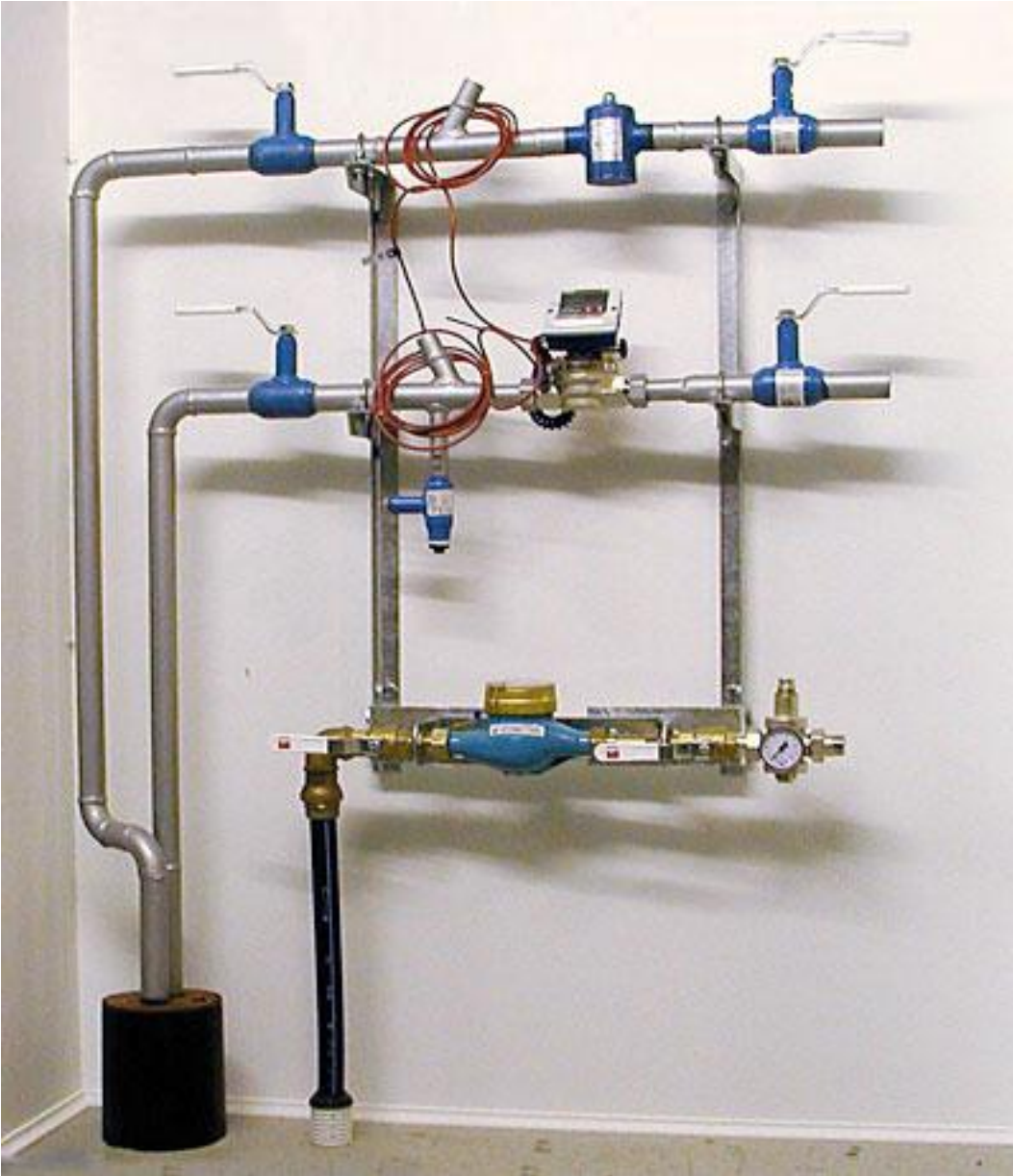
KUVA 11. Kaukolämmön energiakulutuksen mittaaminen. (Kuopion energia, kaukolämmön mittaustekniikka 2008)
