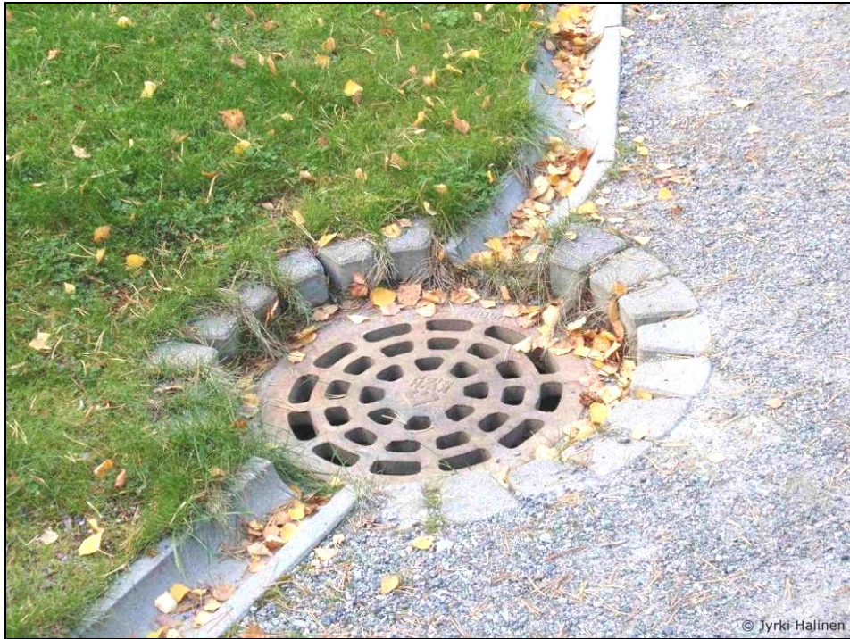
Kuva 10. Hulevesikaivo kourulla. (kuvan lähde: Halinen 2010)
