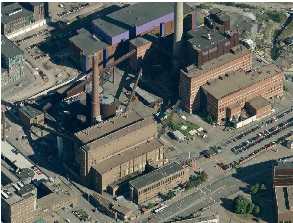
Kuva 1. Ilmakuva Salmisaaren voimalaitoksista (4).
