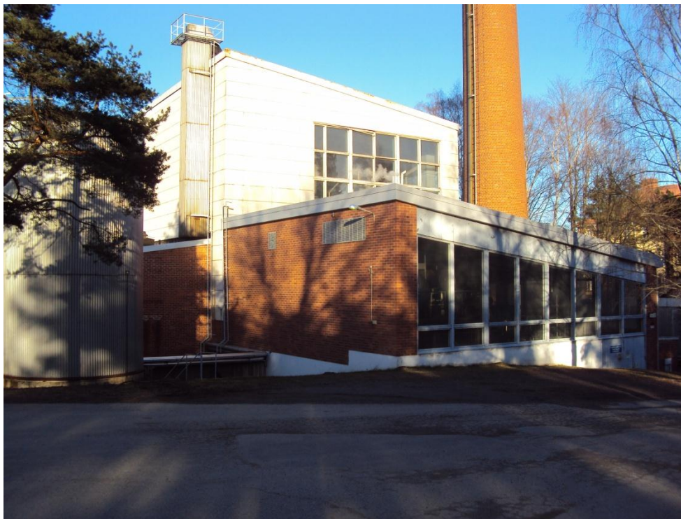
Kuva 12. Kaupunginsairaalan kattilalaitos (KPS, Turun tekstiilihuolto) sisältää kaksi prosessihöyryn tuotannossa olevaa tulitorvi-tuliputkikattilaa.
