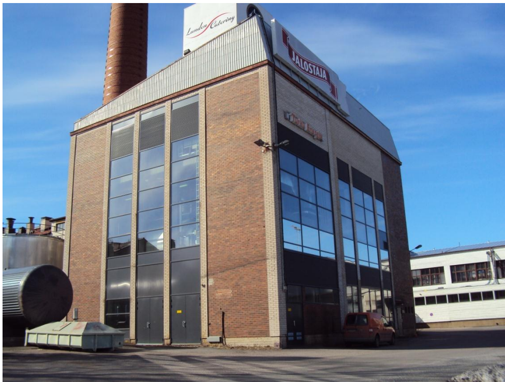
Kuva 15. Jalostajan (JLS) kattilalaitos sisältää kaksi samanlaista tulitorvi tuliputkikattilaa, joiden kummankin teho on 8 MW.
