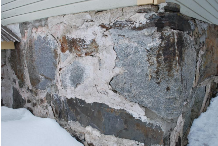
Kuva 6. Luonnonkivisokkeli ja kalkkilaastirappausta Kuvaaja Ari Vatanen
