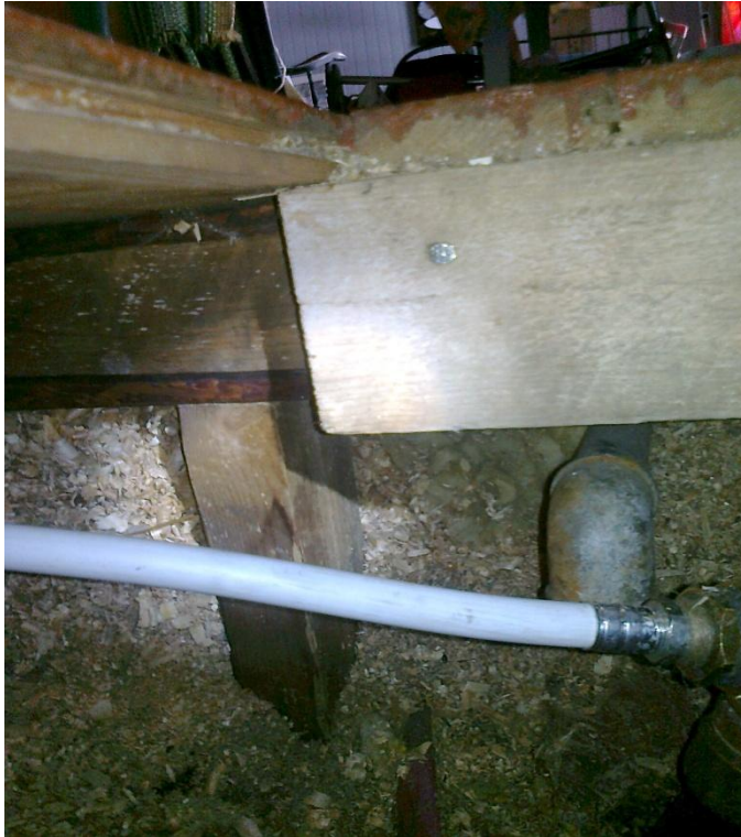
Kuva 5. Sahajauhon ja kutterinlastun sekoitus alapohjassa Kuvaaja Asko Pippuri
