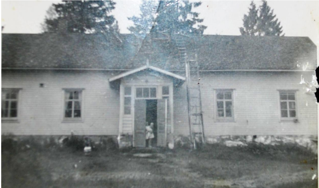
Kuva 10. Julkisivussa lautaverhous, kuva Aune ja Aarne Räsänen hallussa
