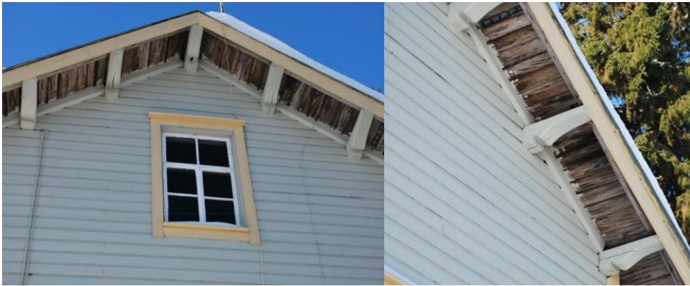
Kuva 2. T-ikkuna ja vuoliaishirsien päät Kuvaaja Ari Vatanen
