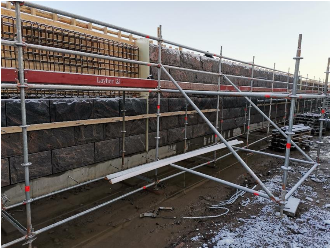
Kuva 9. Rantamuurin kivien- ja muotin asennus käynnissä.
