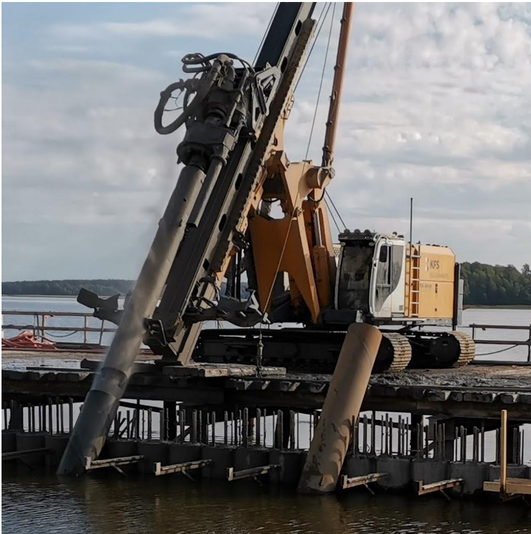
Kuva 5. Vinopaalujen porausta työsillalla.
