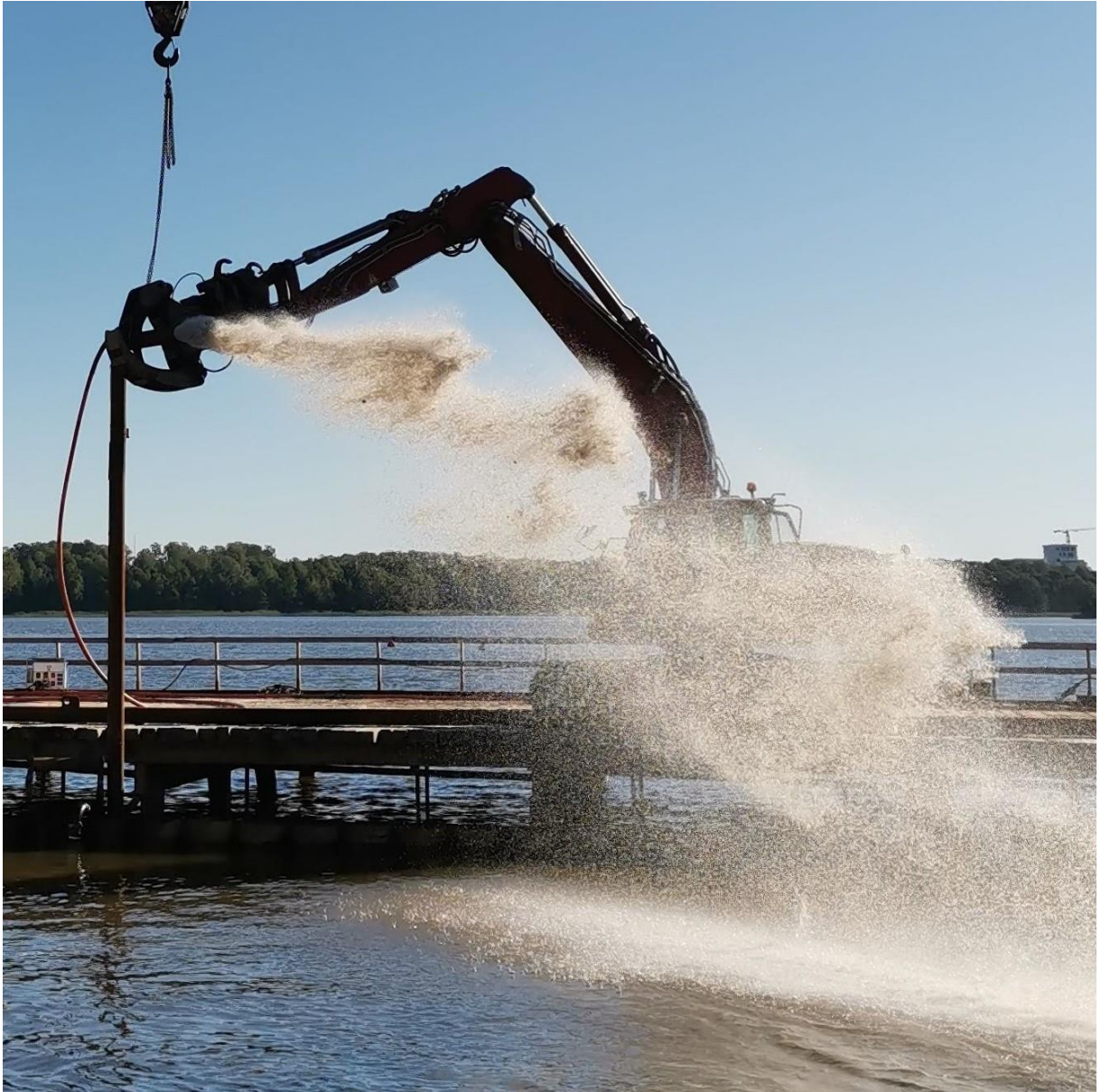
Kuva 13. Paalujen putsausta paineilman avulla.
