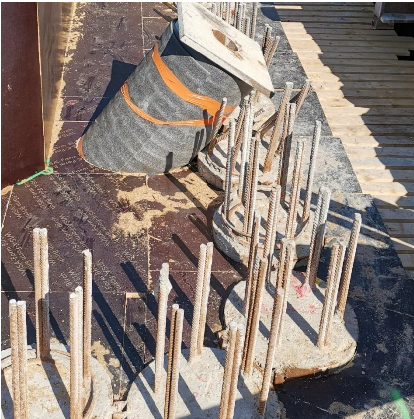
Kuva 7. RD600-pystypaalujen raudoitus.
