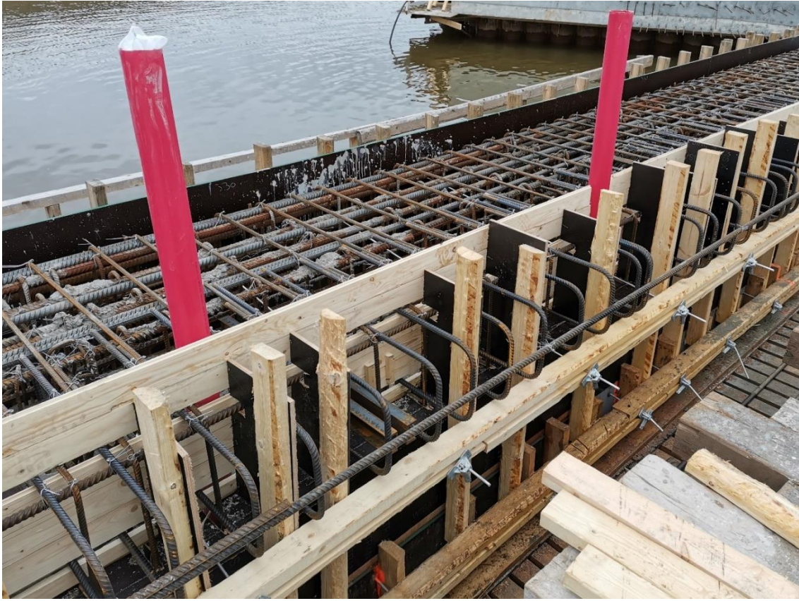
Kuva 8. Rantamuuripalkki valmiina valuun.
