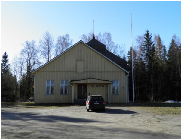
Bild 1: Byggnaden från norr
