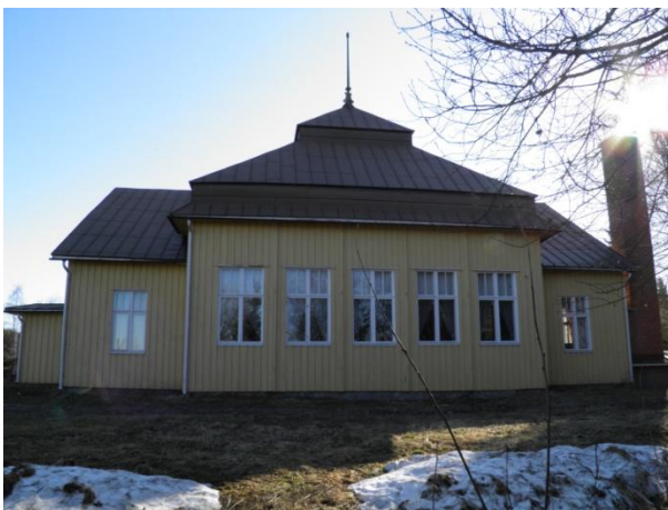
Bild 3: Byggnaden från öst
