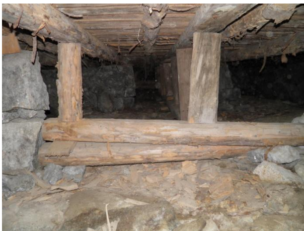
Bild 12: Kryprum, här syns en förstärkning.
