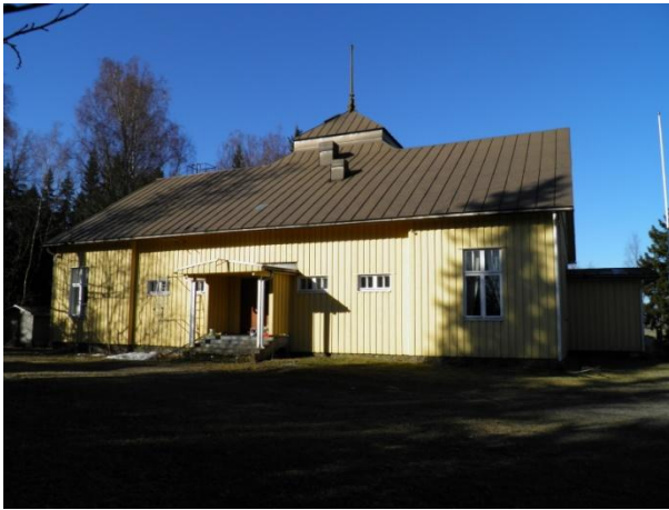
Bild 2: Byggnaden från väst
