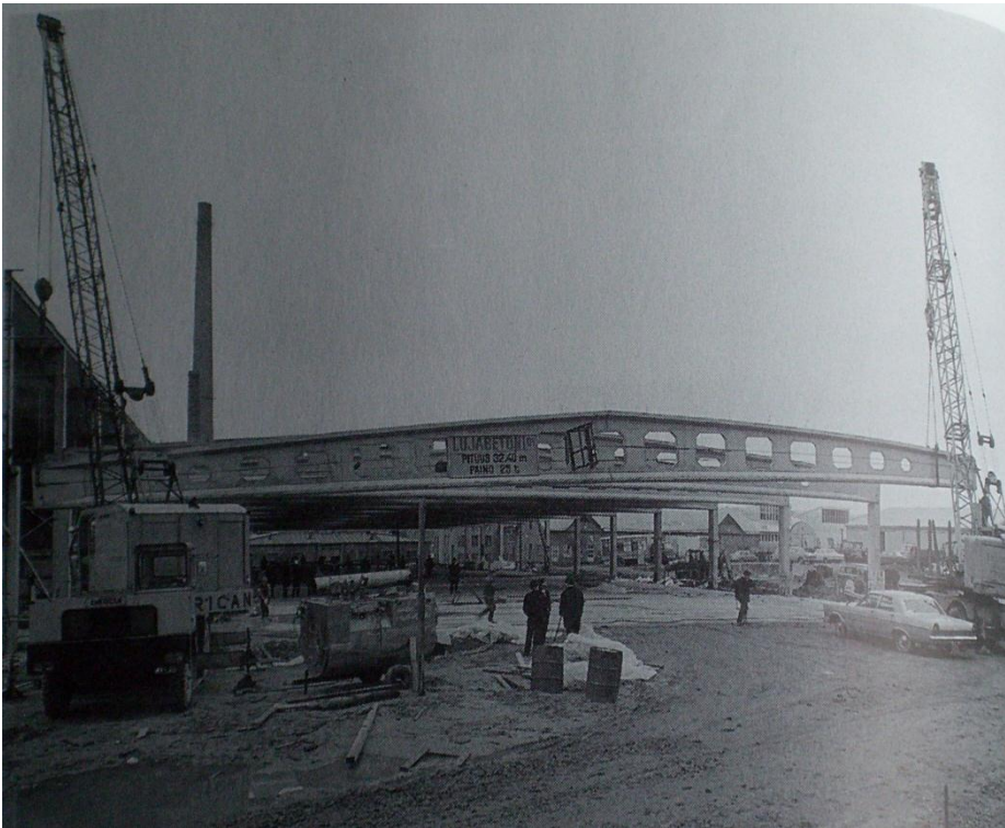
KUVA 2. 32,4 metrin pituisen harjapalkin asennus Kuopiossa (Marketta Isotalo)
