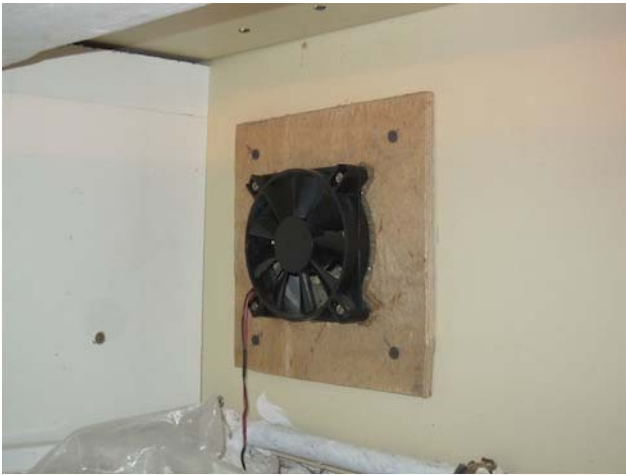
Kuva 11. Lisätuuletin kiinnitetty hormiin teknisessä tilassa
