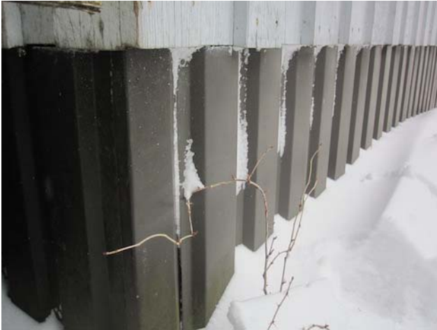
Kuva 1. Muovipintainen pelti betonisen sokkelin päällä
